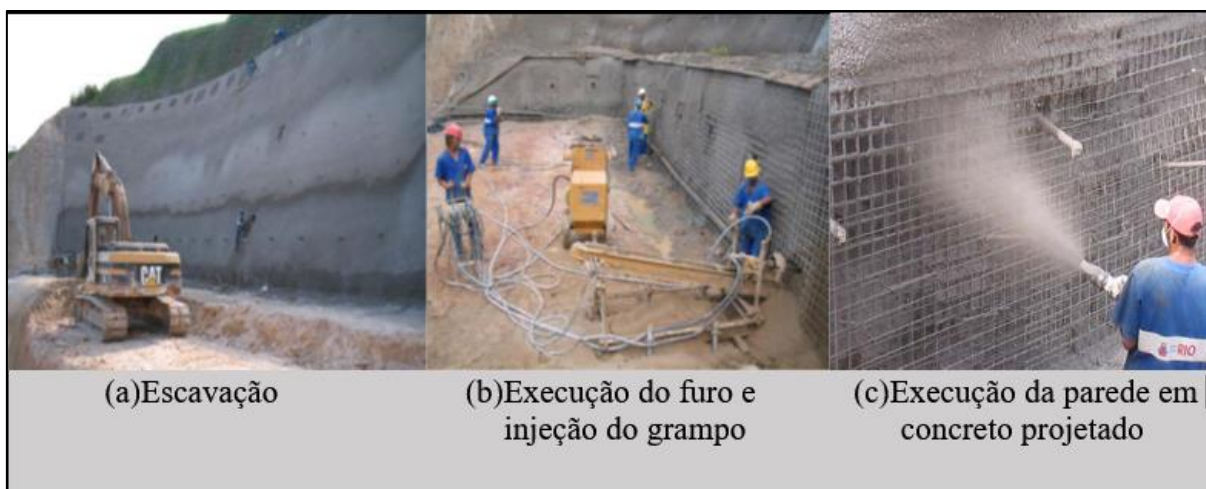
Figura 7 – Principais etapas construtivas em escavações grampeadas.
