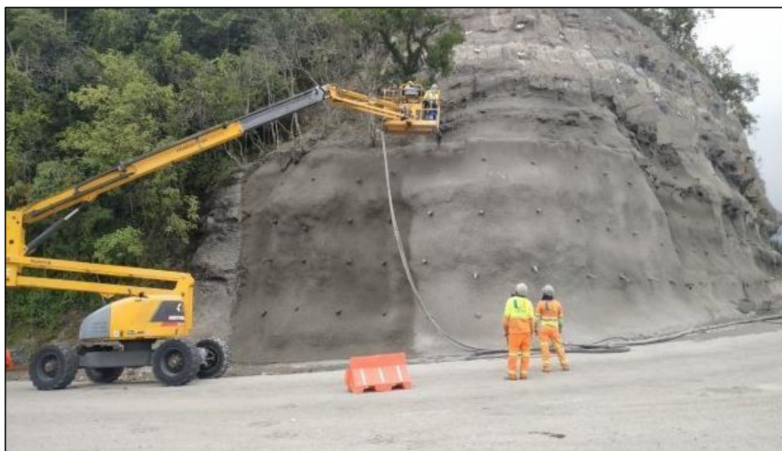
Figura 2 – Contenção de talude rochoso com a técnica de grampeamento de solo na Rodovia SC-390
