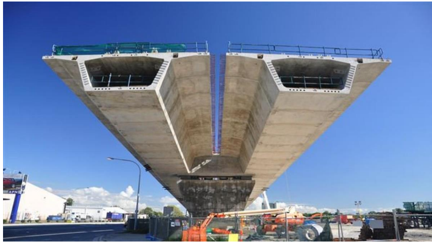
Figura 11 – Vãos em fase construtiva com uso de aduelas pré-moldadas.
