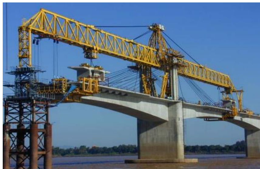
Figura 17 – Vista de uma lançadeira treliçada.
