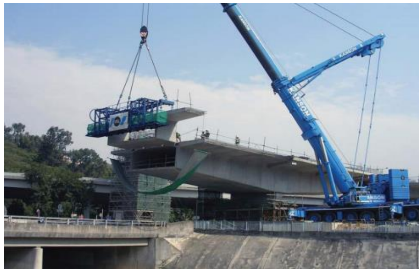
Figura 18 – Lançamento de aduela pré-moldada por meio de grua.
