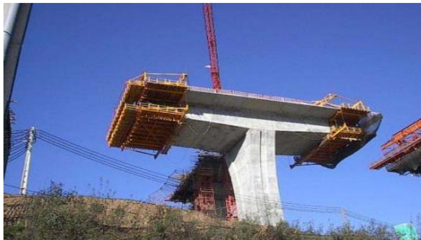
Figura 09 – Execução de aduelas moldadas no local.
