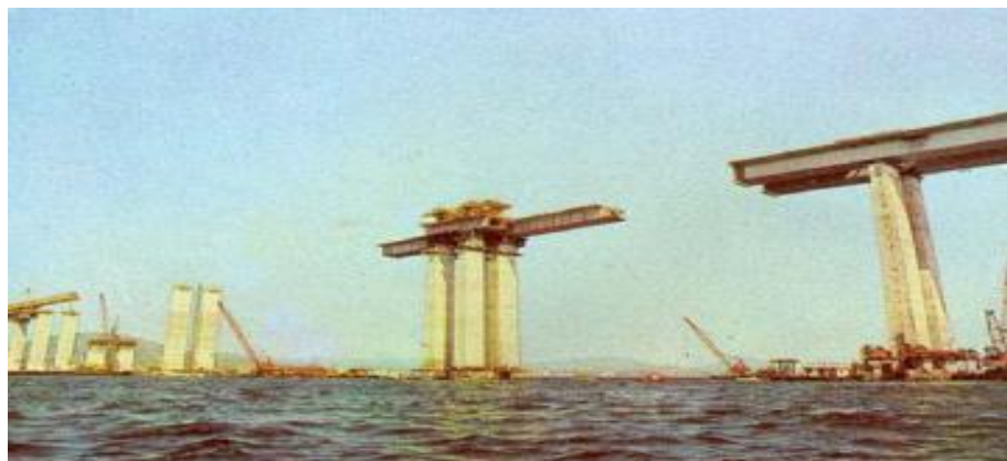
Figura 05 – Construção da ponte sobre o rio Niterói.
