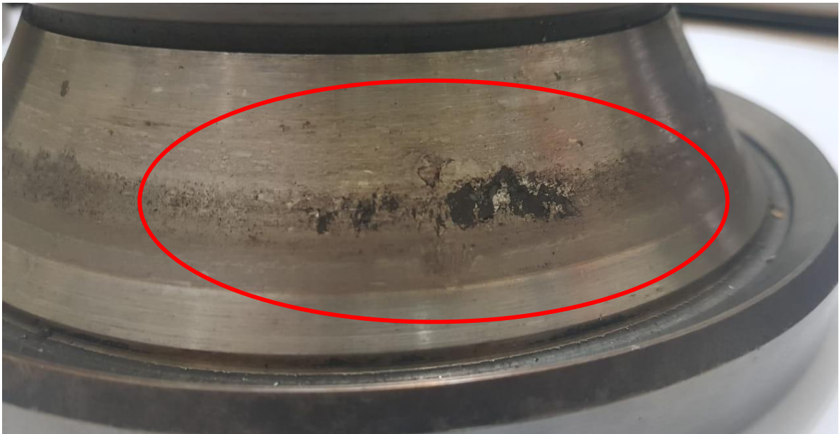
Figura 48 - Ocorrência de descascamento na pista interna
