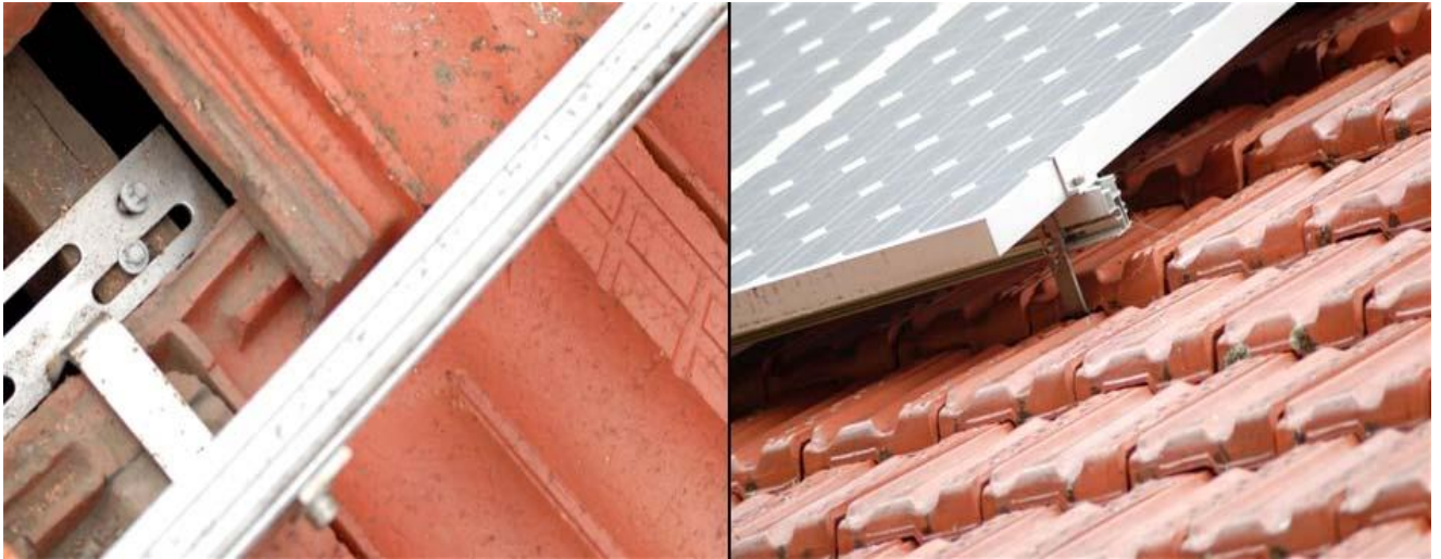
Figura 14: Fixação em telhas de barro usando gancho como interface entre o trilho e a cobertura.
