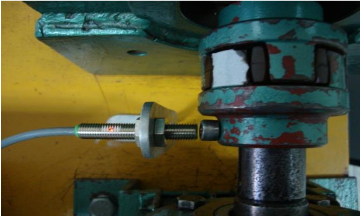
Figura 10 - Instalação transdutor de deslocamento Indutivo
