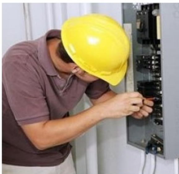
FIGURA 18 – TROCA DE DISJUNTORES EM UM QUADRO DE DISTRIBUIÇÃO
