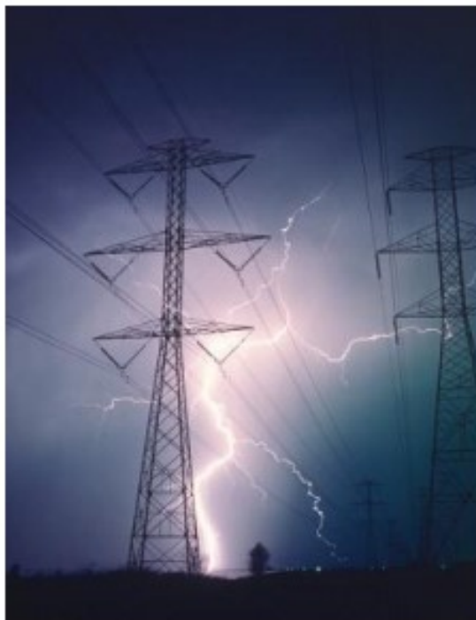
FIGURA 21 - INCIDÊNCIA DE DESCARGAS ATMOSFÉRICAS EM LINHAS DE ALIMENTAÇÃO
