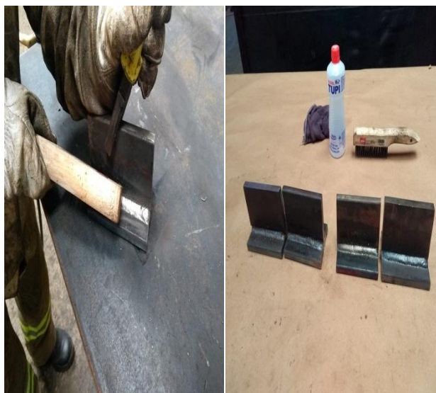
Figura 11: Limpeza das peças com escova manual.
