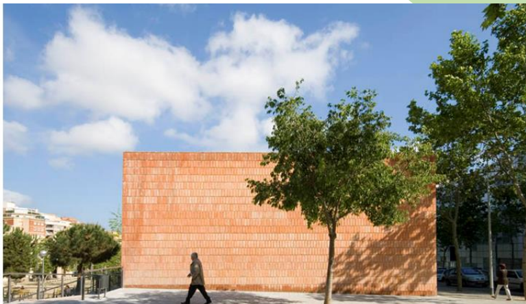
FACHADA LATERAL A RUA
