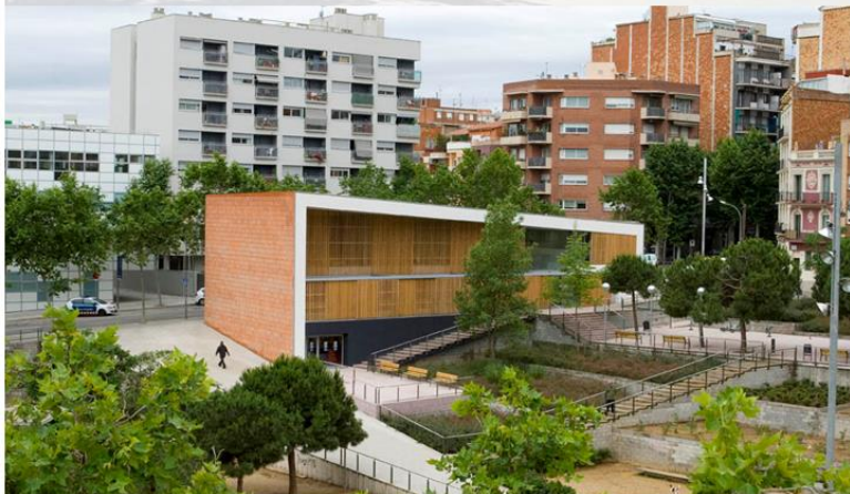
FACHADA LATERAL AO PARQUE
