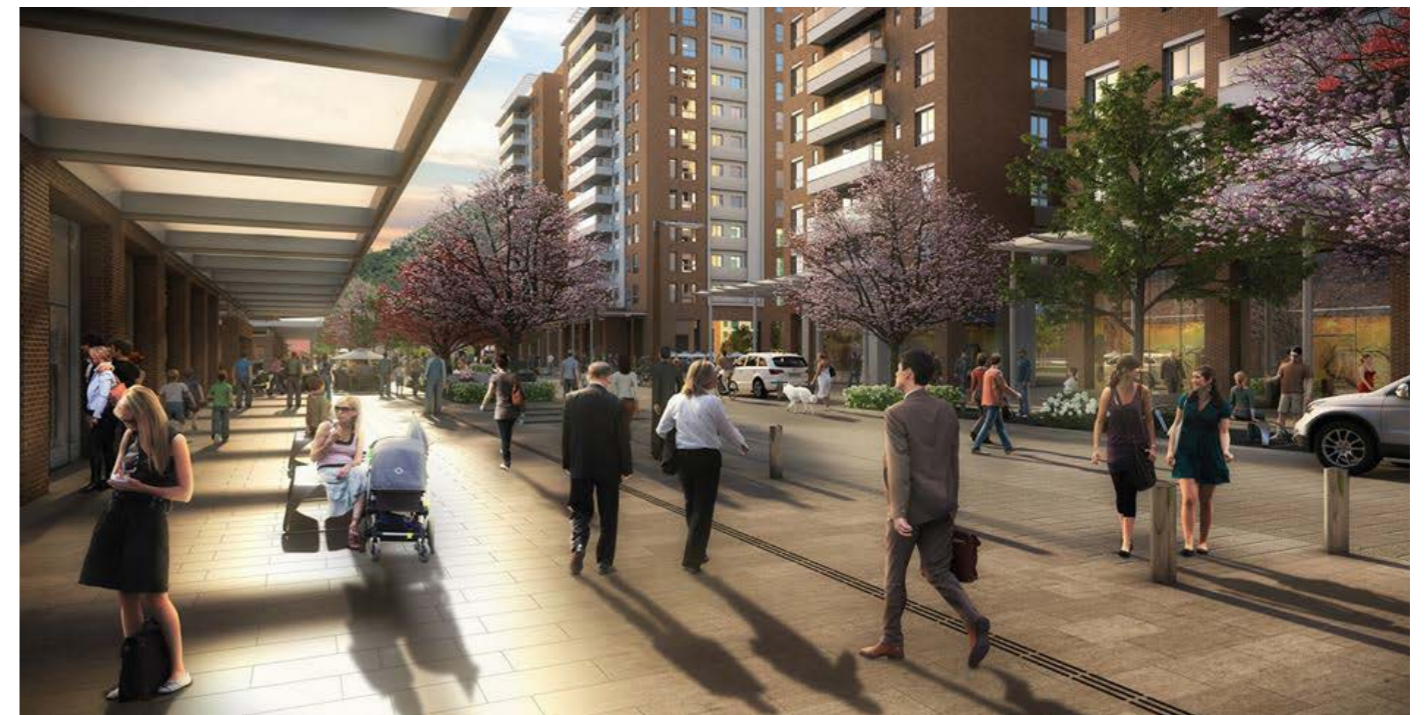
Fonte: Cidade Pedras Brancas
