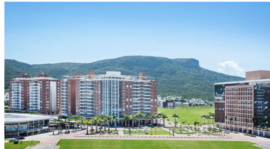
Fonte: Cidade Pedras Brancas
