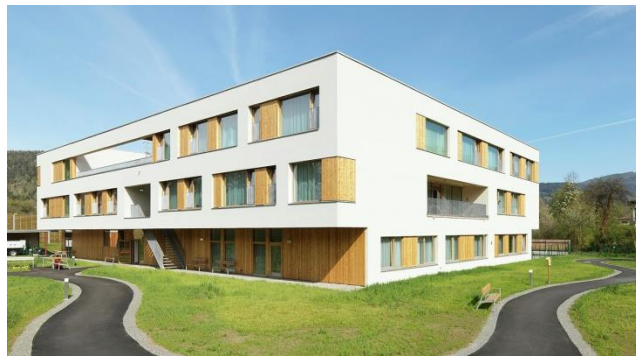
Figura 42: Perspectiva da Fachada Sul e Leste.
