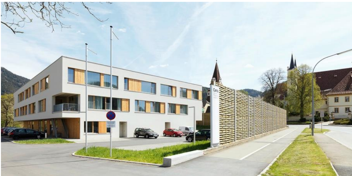
Figura 36: Perspectiva Fachadas Norte e Oeste do Lar de Repouso e Cuidados Especiais. Fonte: Archdaily.
