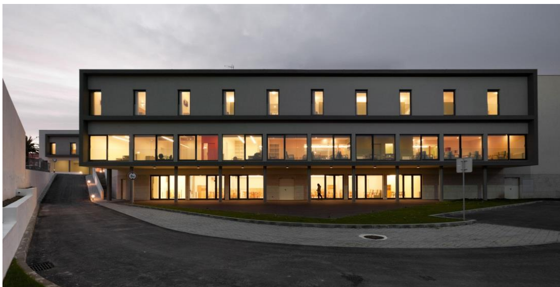
Figura 11: Fachada Frontal Lar de Idosos Parafita, Portugal. Fonte: Arch Daily
