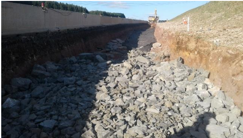
Figura 3 – Reforço do Subleito feito com Pedra detonada
