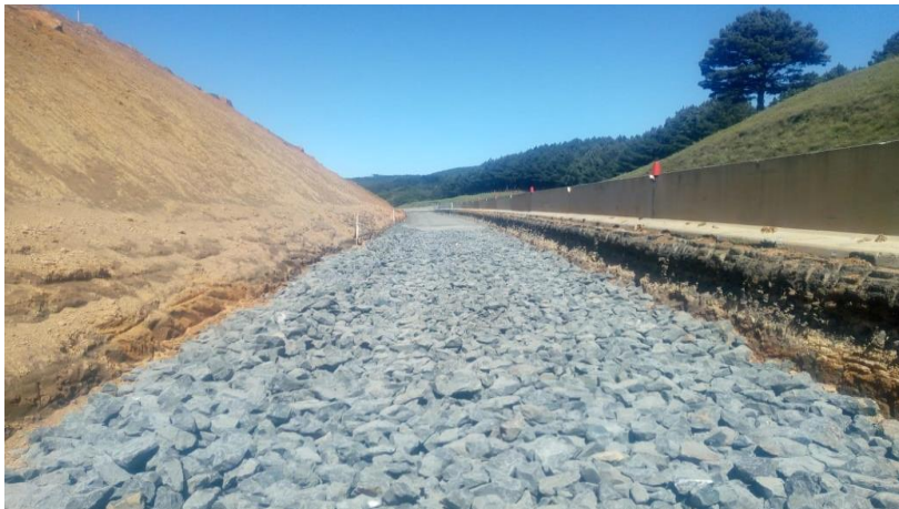
Figura 4 – Reforço do subleito feito com Rachão
