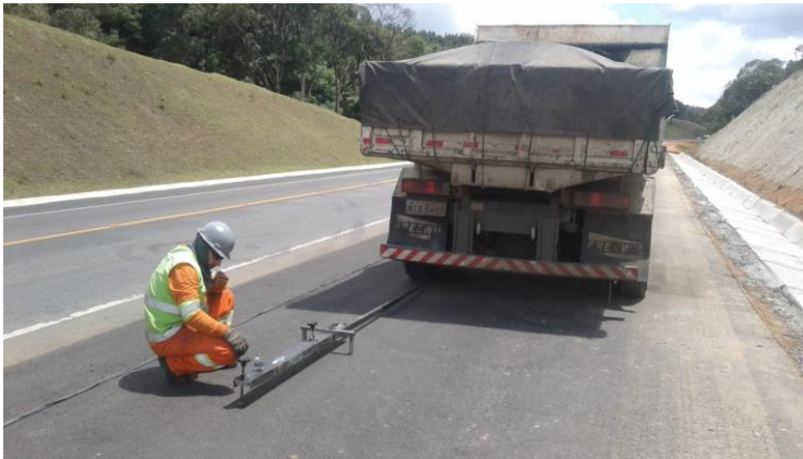
Figura 9 - Viga Benkelman na medição do limite de deflexão
