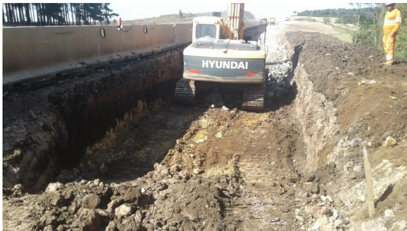
Figura 6 – Escavação para reforço do subleito
