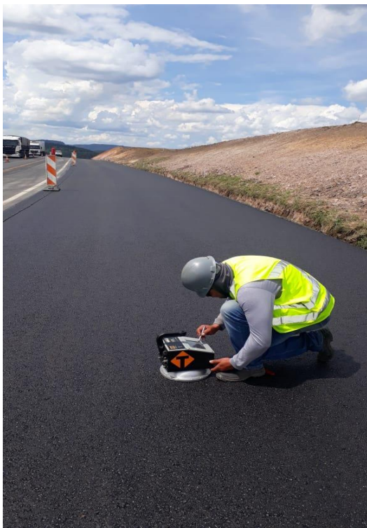
Figura 12 – Análise da camada de CBUQ com densímetro
