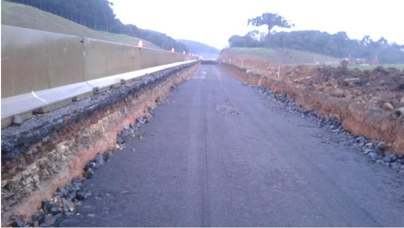
Figura 7 – Reforço do subleito e diferença da estrutura do pavimento antigo.
