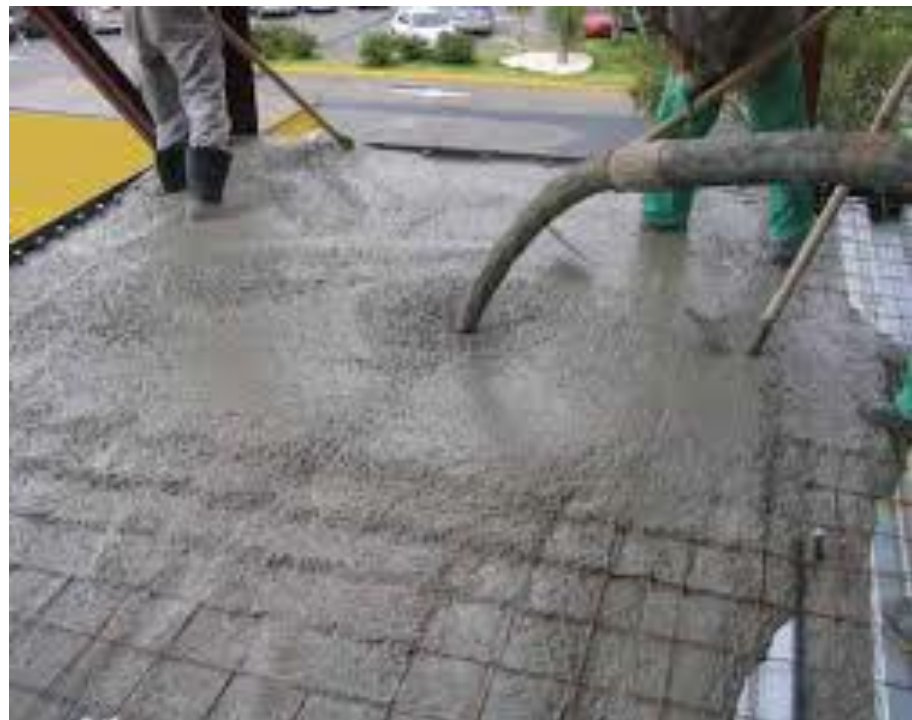
Figura 7: Aplicação de concreto autoadensável (CAA)
