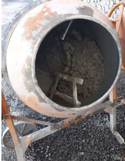
Figura 10: Mistura na Betoneira
