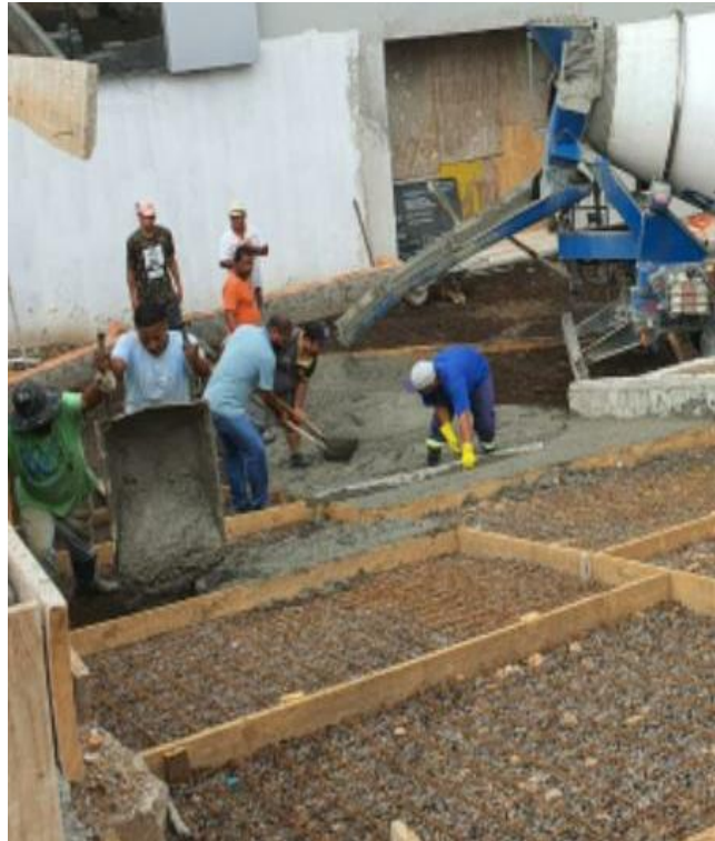
Figura 3. Concretagem com descarga convencional
