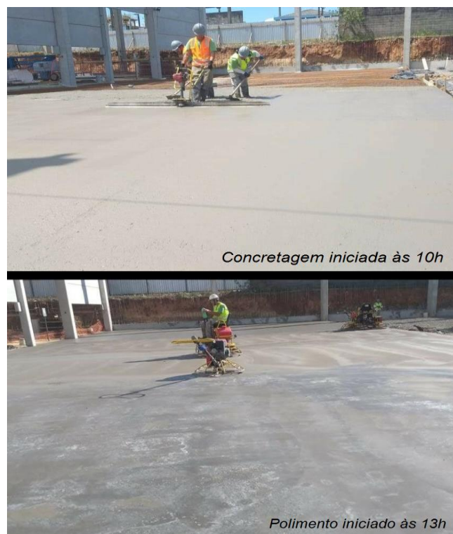
Figura 4. Concretagem e polimento de piso industrial
