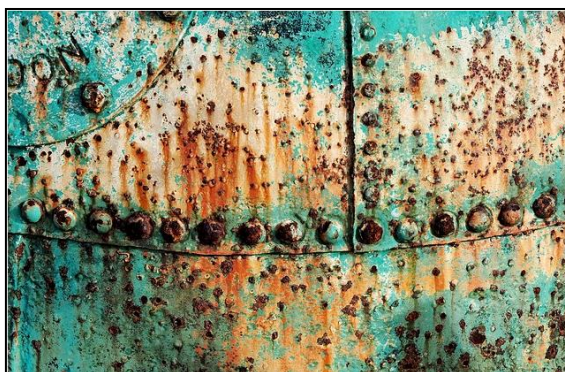
Figura 16 – Ação Corrosiva da água do mar em boia marítima
