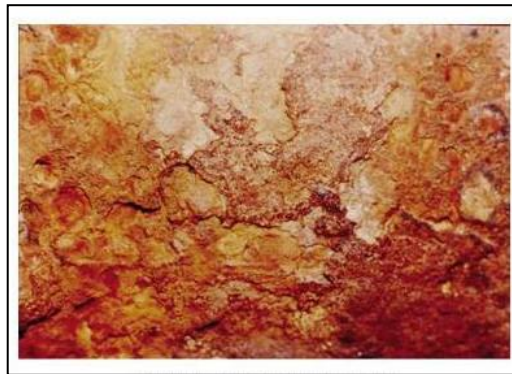
Figura 2 – Corrosão uniforme em chapa de aço carbono
