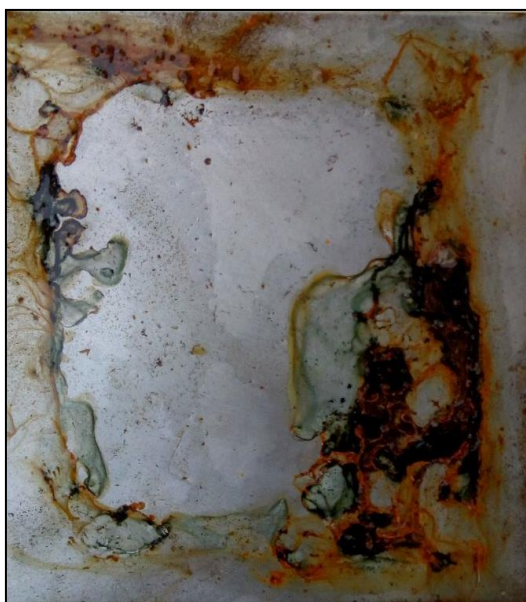
Figura 26 – Corrosão no aço carbono SAE 1020 - Material exposto em Lages SC
