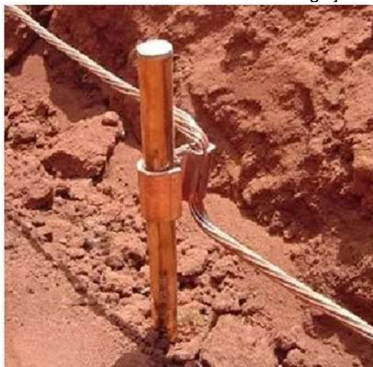
Figura 17 – Haste de Aterramento com interligação de Malha.
