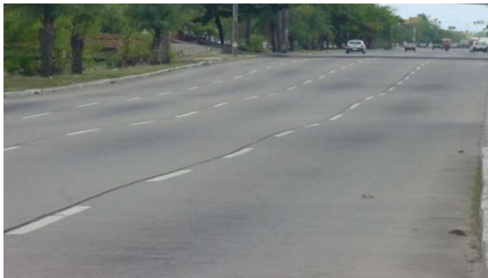
Figura 25 – Assentamento da via.
