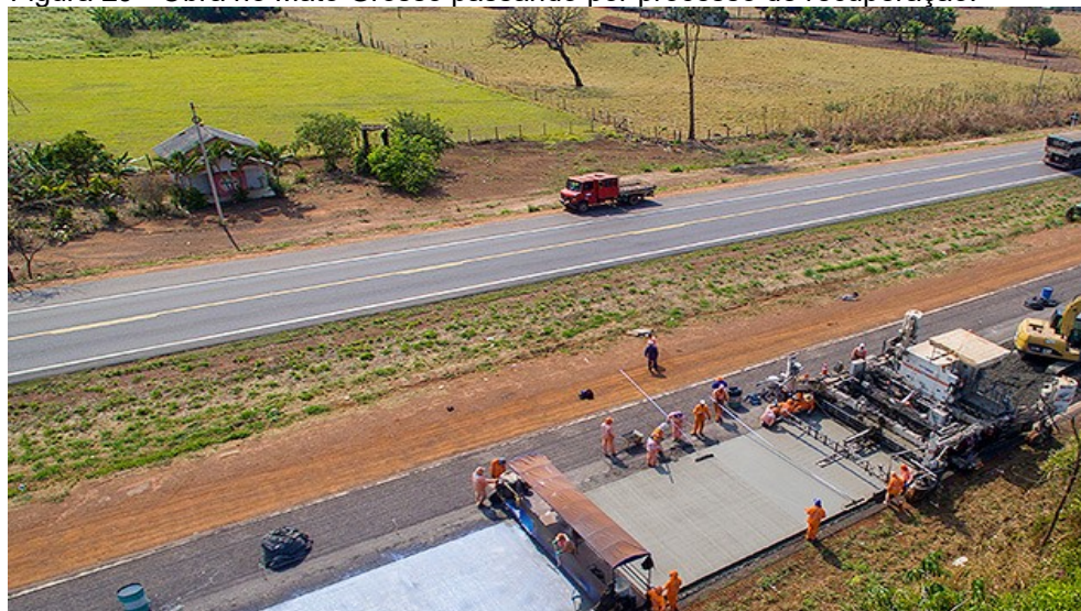
Figura 29 - Obra no Mato Grosso passando por processo de recuperação.
