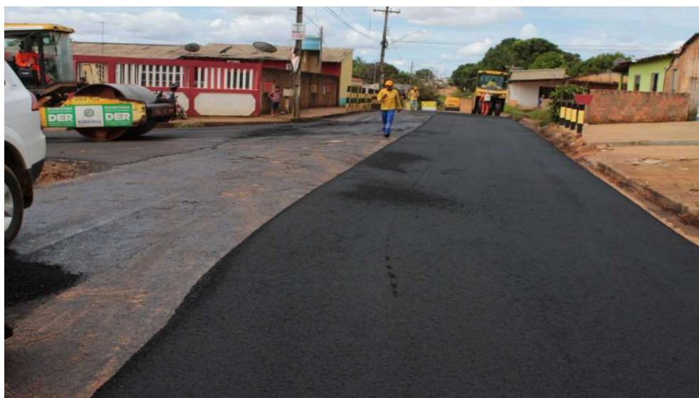
Figura 27- Faixa de rolamento em processo de recapeamento.
