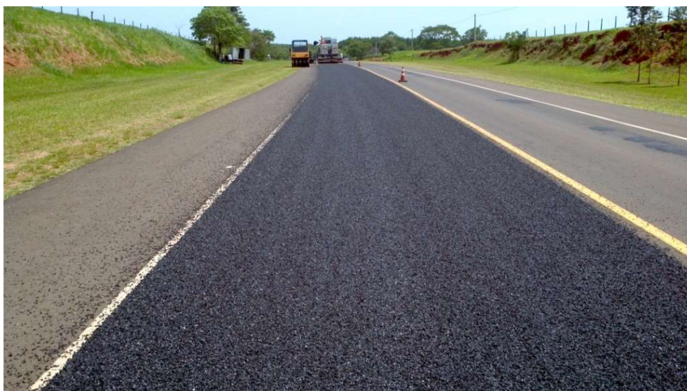
Figura 32- Asfalto modificado por Borracha (AMB) .
