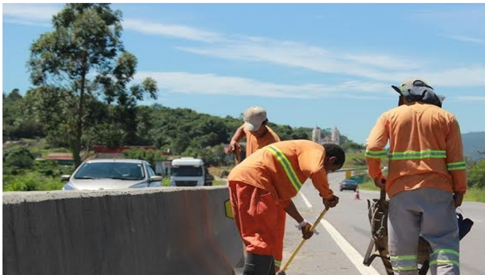
Figura 28 – Trabalhadores realizando limpeza ao longo das vias.
