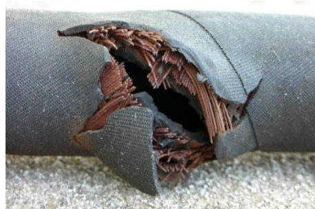
Figura 21 – Mangueira estourada devido excesso de pressão.
