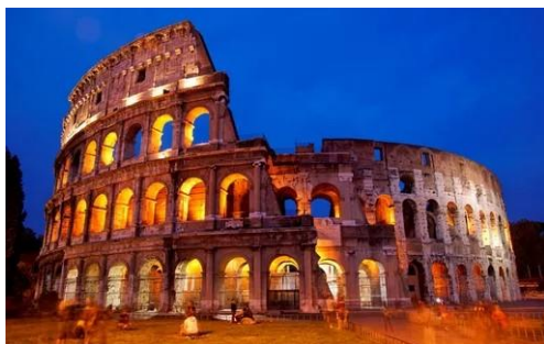
Figura 3 – Coliseu (Roma) – Fundações e diversas paredes
