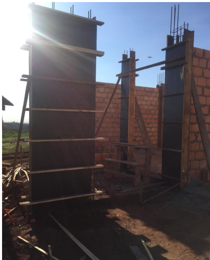
Figura 7 – Fôrmas dos pilares prontas para concretagem
