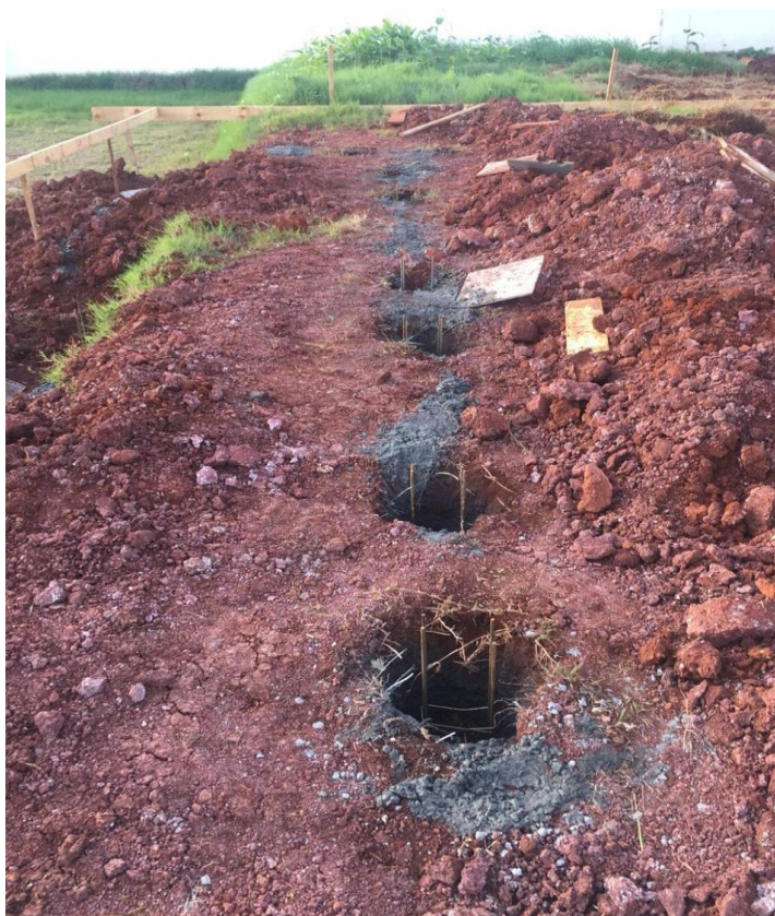
Figura 6 - Concretagem das estacas de fundação
