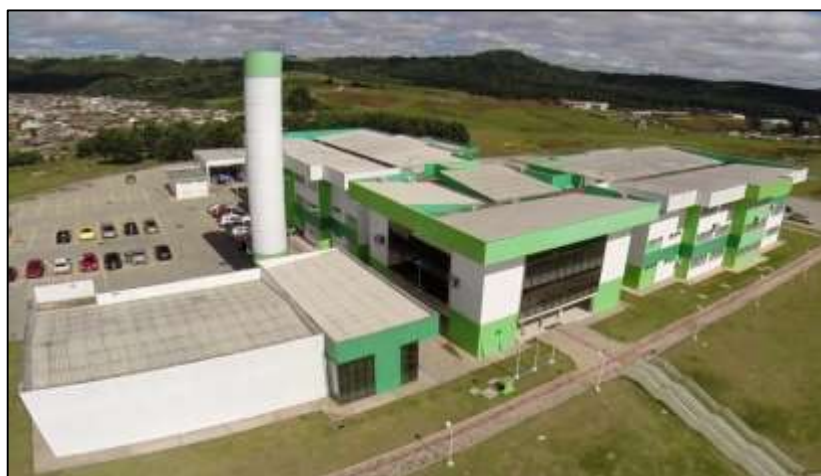
Figura 42 – Local de instalação do sistema.
