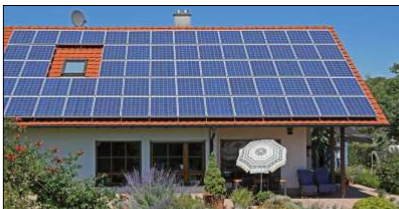
Figura 34 – Sistema de microgeração fotovoltaica em uma residência.
