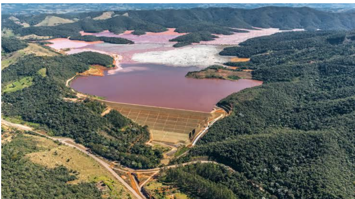
Figura 2: Dique B3 Ipê, a segunda barragem com maior potencial de risco, localizada no município de Itabiruçu-MG. Fonte: De Fato
