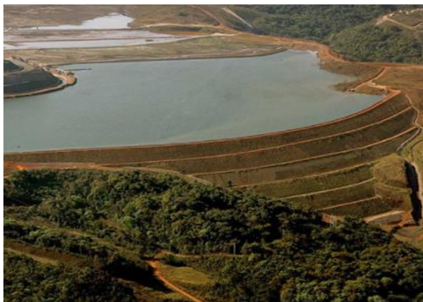
Figura 07: Barragem de Rejeito de Minério. Fonte: Vale
