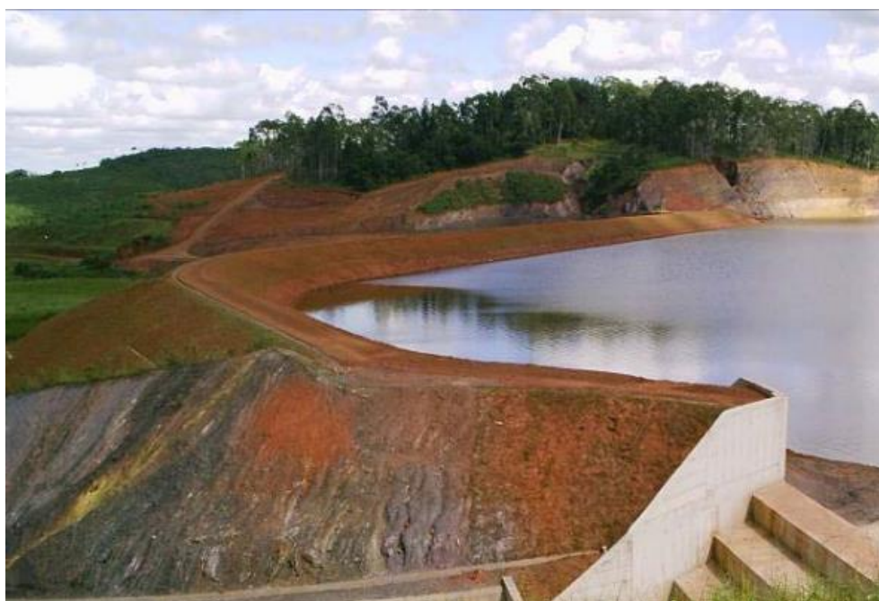
Figura 08: Barragem Casa de Pedra, Congonhas-MG. Fonte: Companhia Siderúrgica Nacional -CSN
