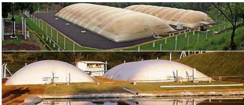
Figura 1. Ilustração de biodigestor canadense:
