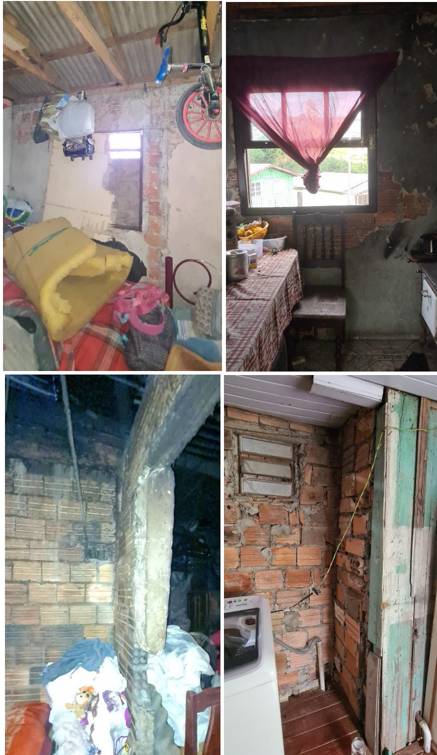
Figura 9 - Ausência ou condições precárias de reboco interno nas paredes de alvenaria das moradias
