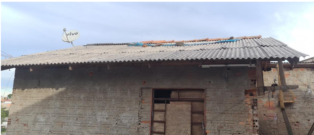
Figura 12 - Cobertura de telha amianto composta também por lona e cumeeira cerâmica
