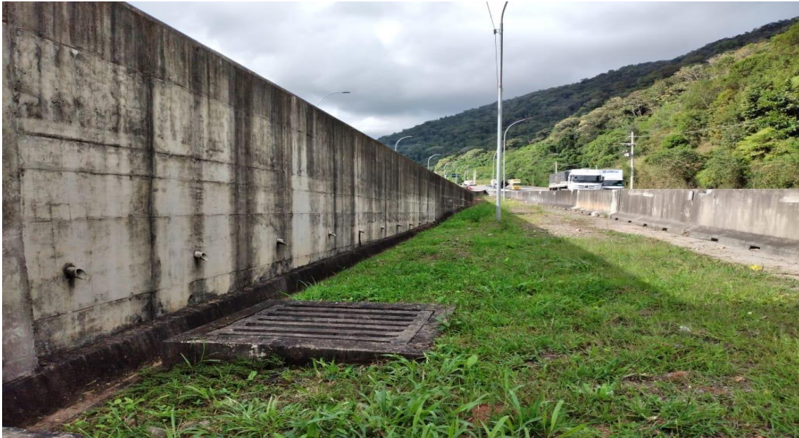
Figura 06: Canaleta para passagem de água [Autor]
