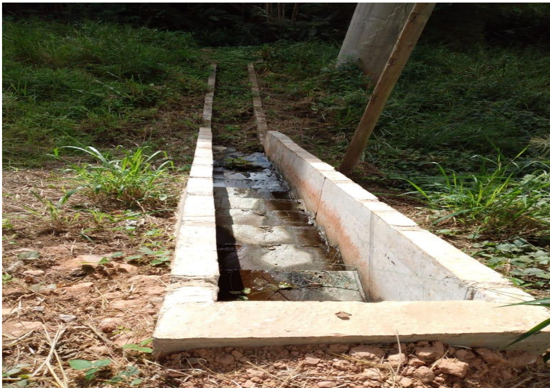
Figura 05: Dissipador de energia após o tratamento dos resíduos [Autor]
