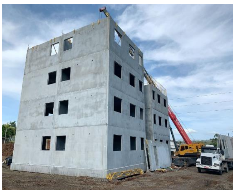
Figura 7 – Sistema de painéis pré-moldados.
