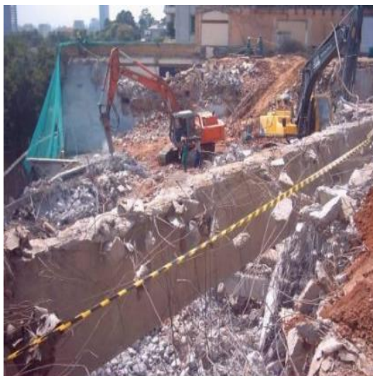
Figura 2 – Resíduo gerado no serviço de demolição
