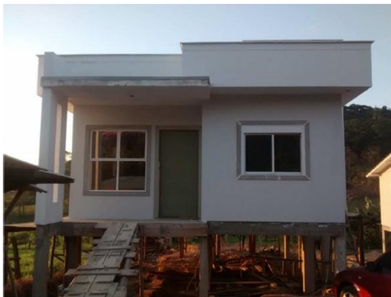
Figura 10 – Obra na fase de pintura.
