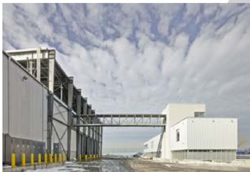
Figura 9: Imagens do Projeto Sunset Park Fonte: Selldorf Architects
