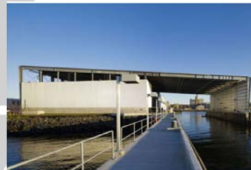
Figura 8: Imagens do Projeto Sunset Park Fonte: Selldorf Architects
