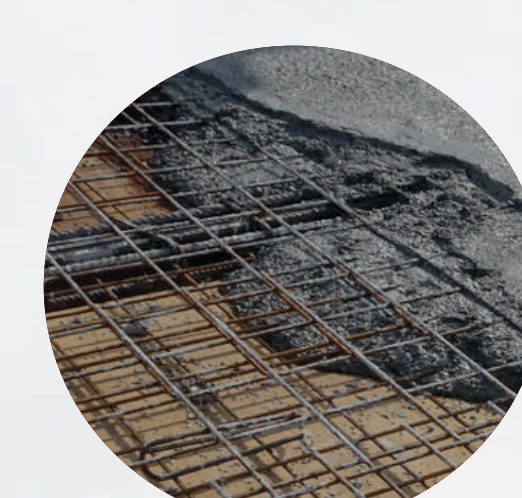
Laje de concreto convencional
