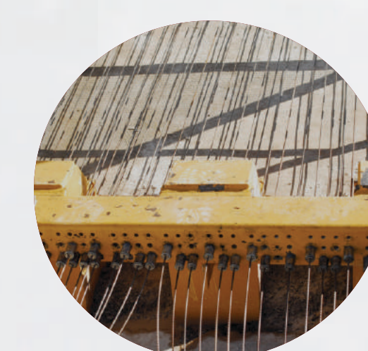
Laje de concreto profundida
