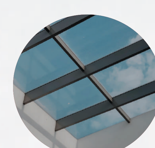
Cobertura de vidro
