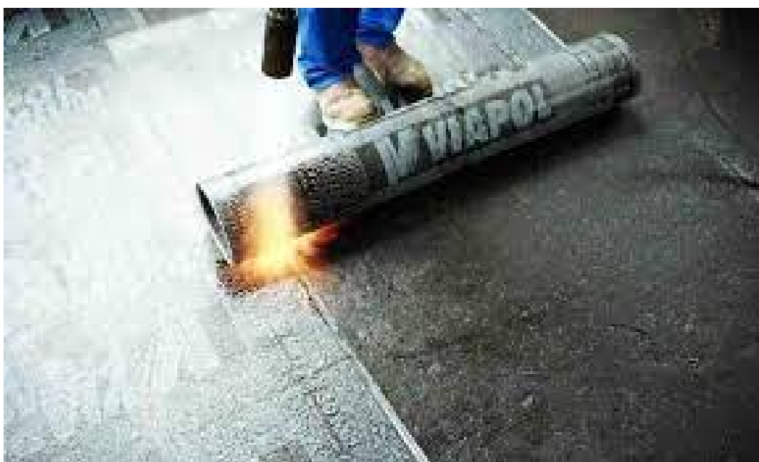
Figura 19 – Aplicação de manta asfáltica com maçarico.
