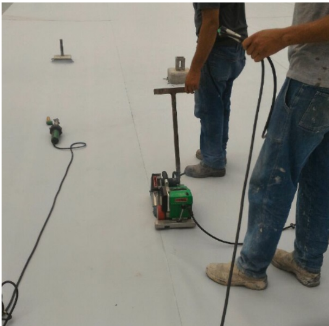
Figura 20 – Processo de emenda da manta com equipamento automático.
