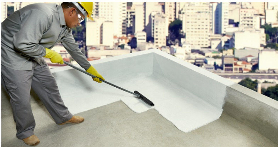
Figura 17 – Aplicação de membrana acrílica
