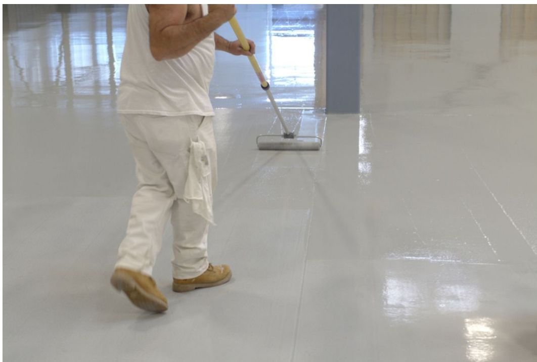
Figura 13 – Aplicação de impermeabilização a base de resina epóxi
