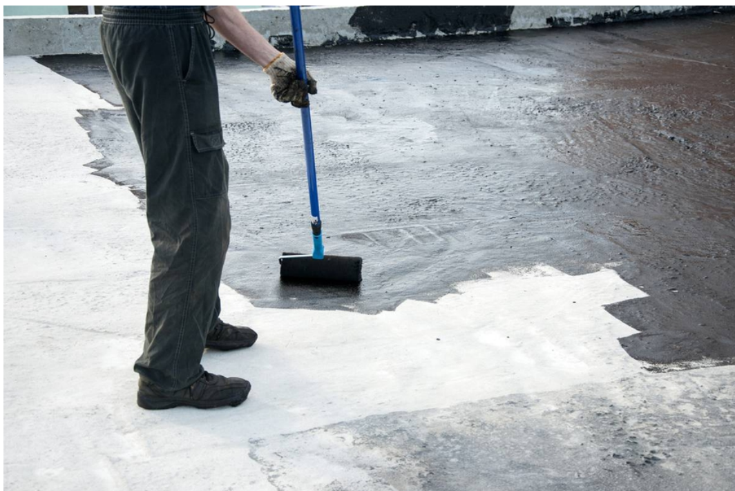
Figura 15 – Execução de membrana de asfalto a frio com rolo de pintura.
