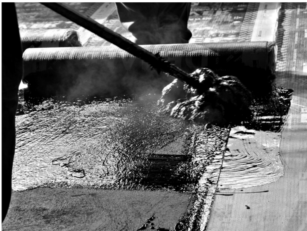
Figura 16 – Execução de membrana de asfalto a quente.
