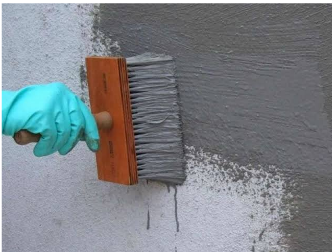
Figura 11 – Aplicação da argamassa polimérica
