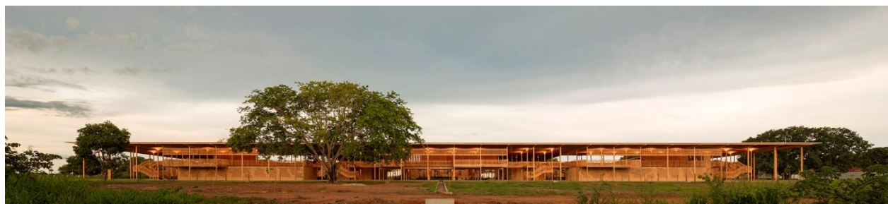
Imagem Fachada – Moradias Infantis
