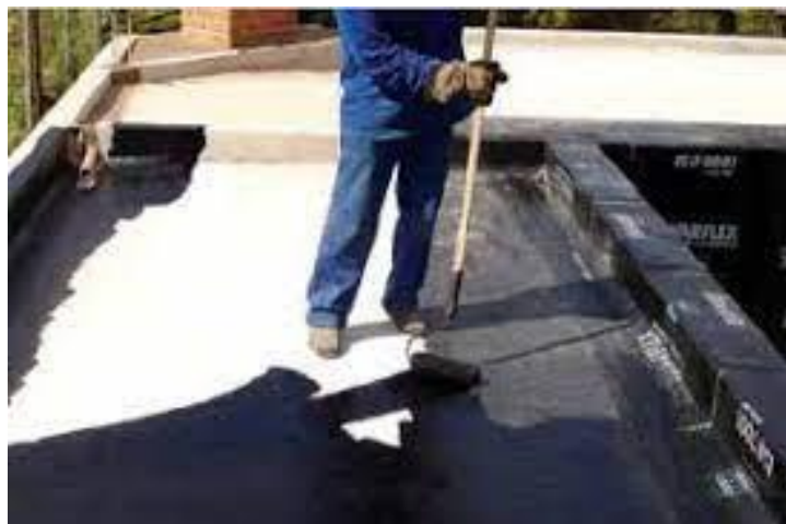
Figura 14 - Execução de membrana asfáltica à frio.
