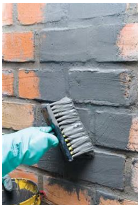
Figura 12 - Aplicação de cristalizante na forma de pintura.
