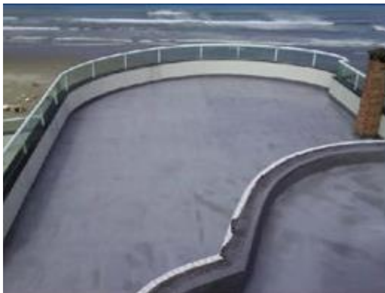
Figura 16 - Laje exposta à maresia impermeabilizada com membrana acrílica.
