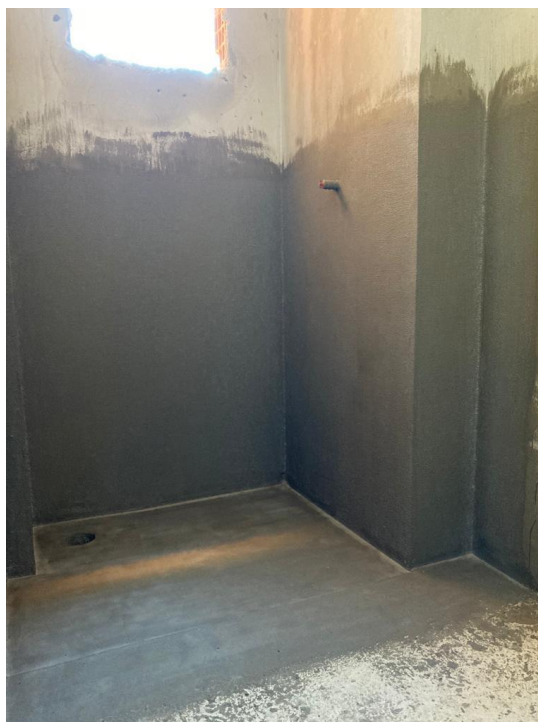
Figura 11 – Box de banheiro impermeabilizado com argamassa polimérica.
