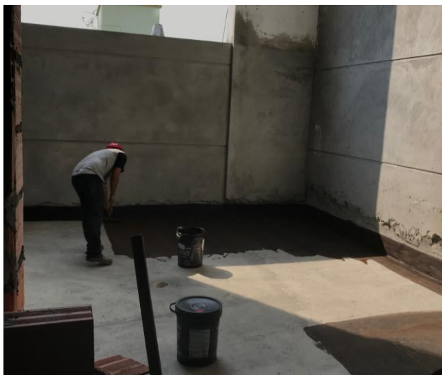
Figura 17 - Cobrimento da superfície com emulsão asfáltica.
