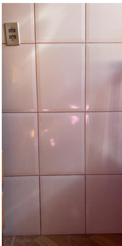
Figura 26 - Parede do dormitório revestida com azulejos.
