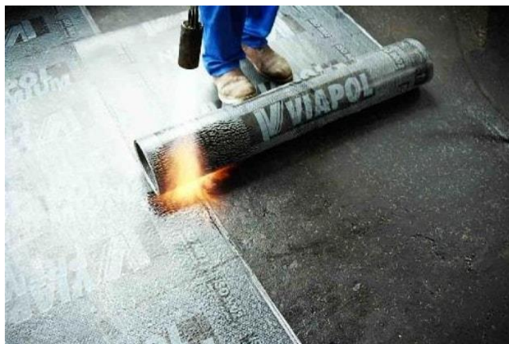
Figura 20 - Colagem da manta asfáltica.
