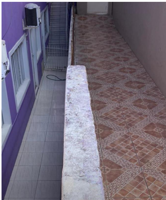
Figura 34 - Diferença de nível entre os terrenos.
