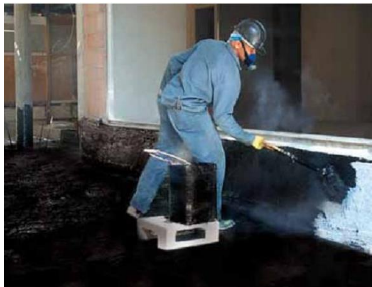
Figura 15 - Execução de membrana asfáltica à quente.
