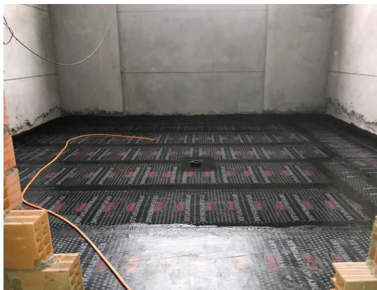
Figura 21 - Teste de estanqueidade.
