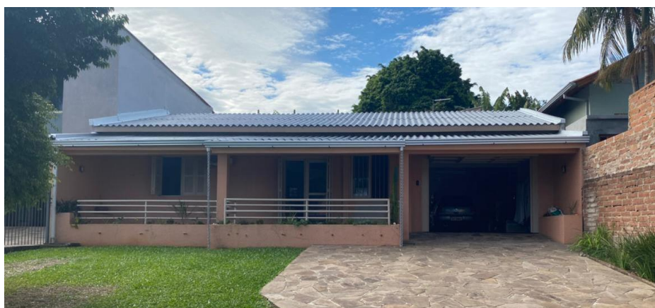
Figura 23 - Edificação do estudo de caso I.
