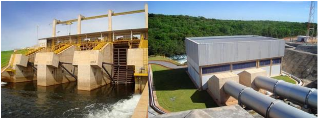
Figura 13 – Imagem de uma tomada d'água e conduto forçado.
