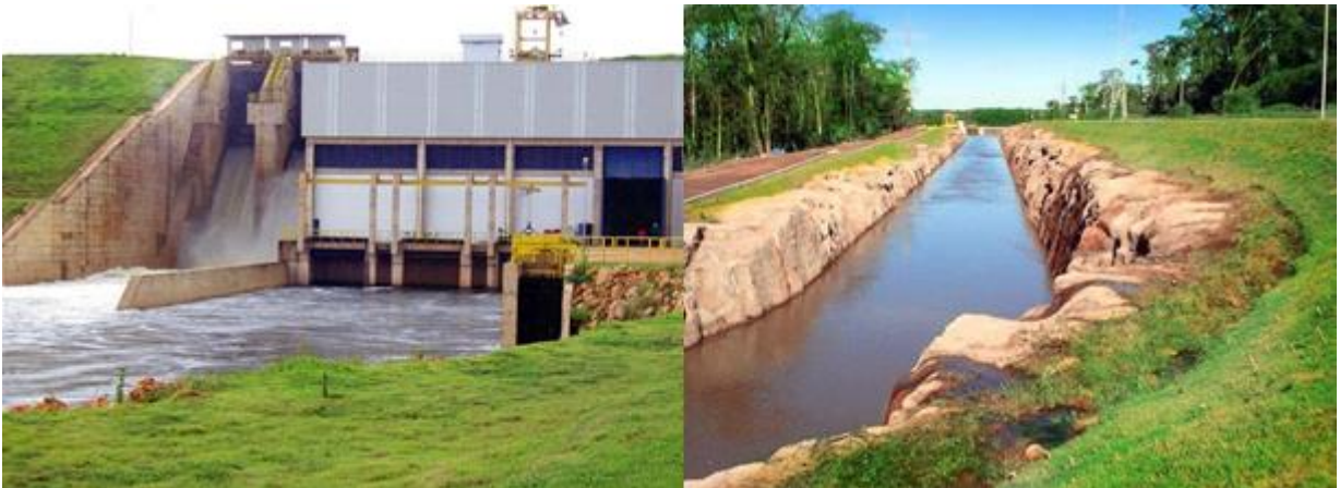
Figura 12 – Imagem de um vertedouro e canal de adução
