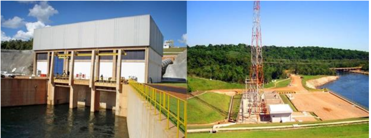
Figura 14 – Imagem de uma casa de força e subestação.
