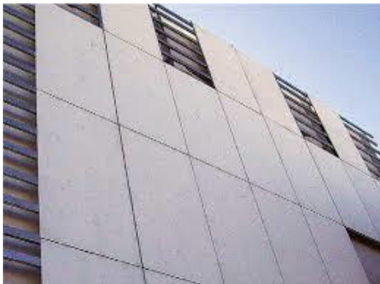
Figura 30 - PLACAS CIMENTÍCIAS INDUSTRIALIZADOS
