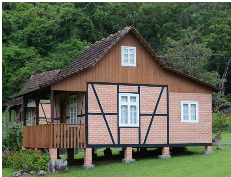
Figura 25 - Restaurante e Pousada Rural Mundo Antigo – Enxaimel Fonte: < https://www.google.com/maps/contrib/105674213828292605248/photos/@-23.6684831,-46.5326702,7z/data=!3m1!4b1!4m3!8m2!3m1!1e1 > Acesso em: 16 de julho. 2017
