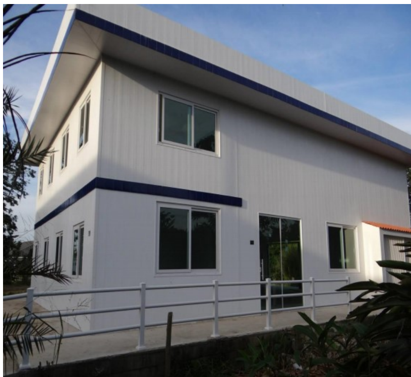
. Figura 14 – Obra executada com o sistema Concreto-PVC.
