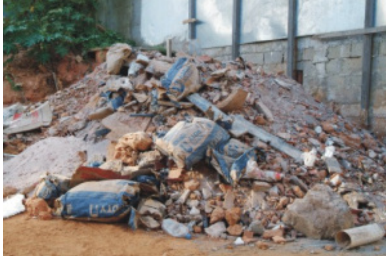
Figura 1 – Resíduos da construção civil I.
