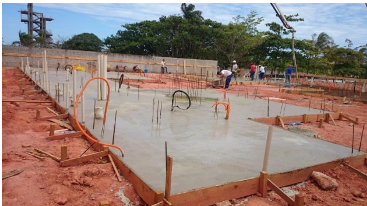
Figura 12 – Fundação em Radier após a concretagem.
