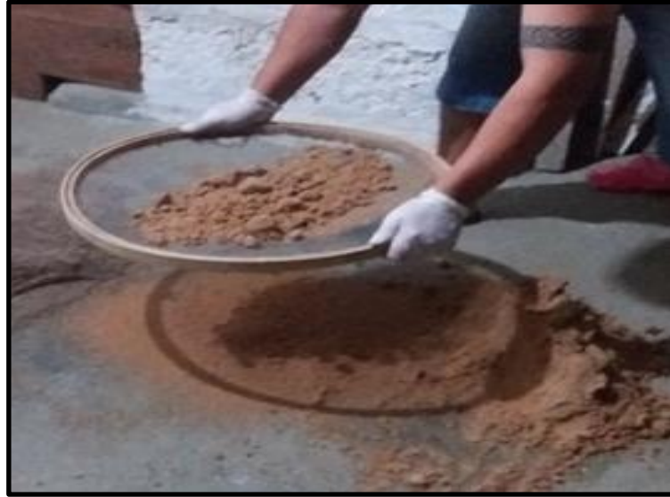
Figura 11 : Processo de peneiramento da areia
