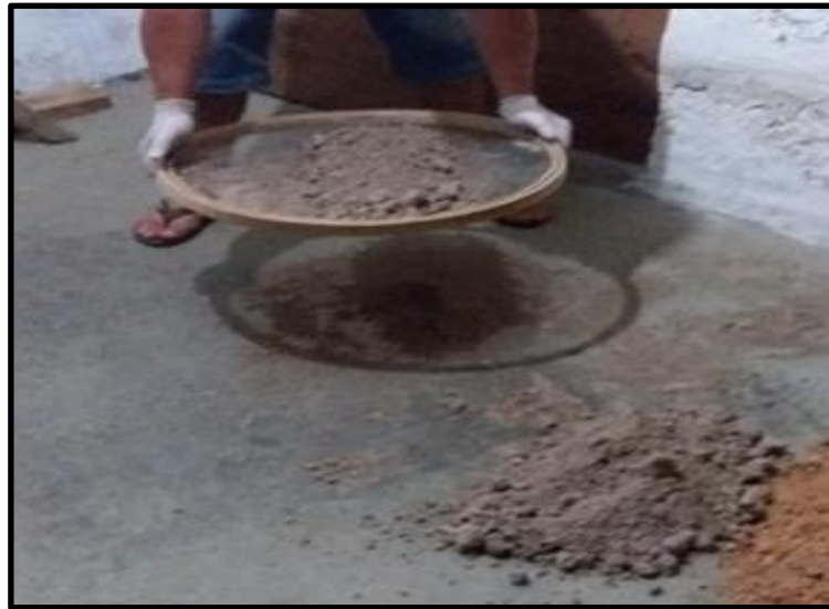
Figura 10 : Processo de peneiramento da terra diatomácea
