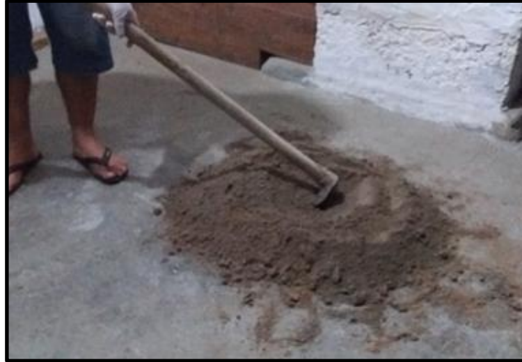
Figura 13 : Processo de mistura para confecção dos tijolos
