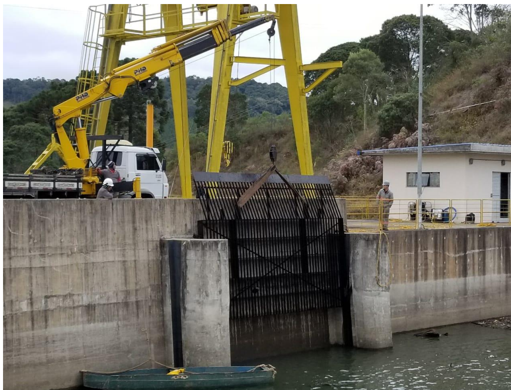
Figura 38 – Grade de entrada do conduto adutor, Usina Pery, Curitiba SC.
