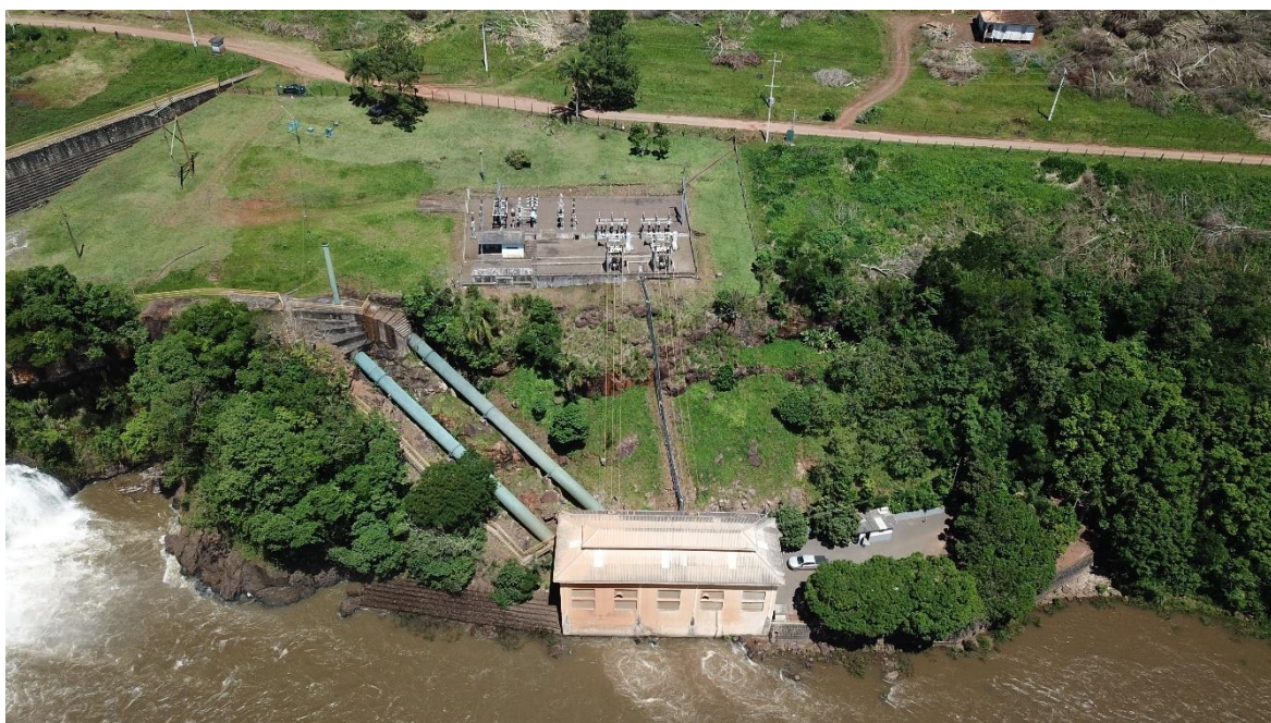
Figura 15 - Casa de Força, Usina Celso Ramos, Faxinal dos Guedes SC.
