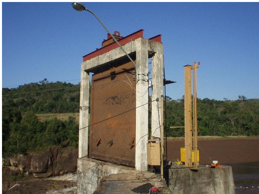
Figura 12 - Comporta Vagão, Usina Celso Ramos, Faxinal dos Guedes SC.
