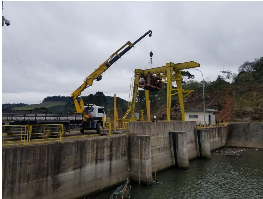
Figura 11 Tomada de Água, Usina Pery, Curitibaanos SC.
