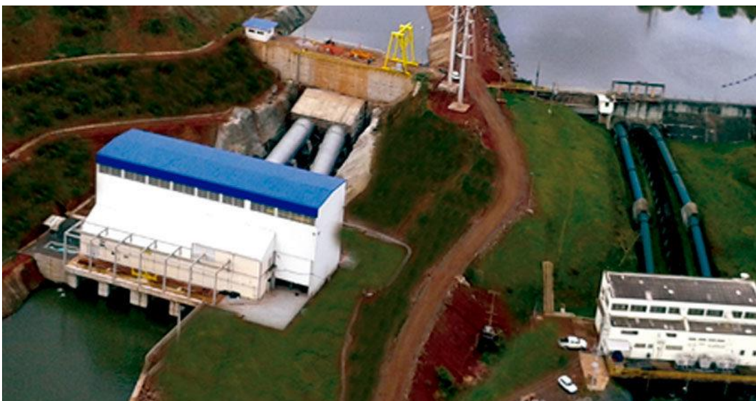
Figura 29 – Casa de força Usina Pery, Curitibaanos SC.
