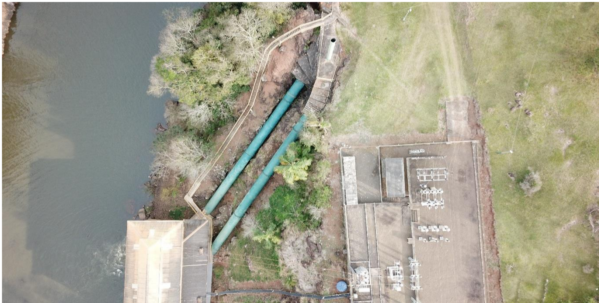
Figura 14 - Conduto Forçado, Usina Celso Ramos.
