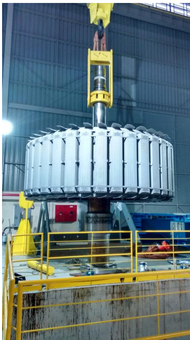
Figura 41 – Ponte rolante casa de força, içando Rotor do Gerador, Usina Pery, Curitibaanos SC.
