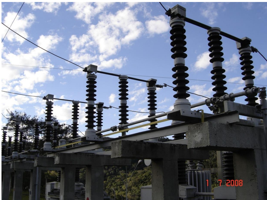
Figura 59 - Chave seccionadora tripolar, Usina Celso Ramos, Faxinal Dos Guedes SC.
