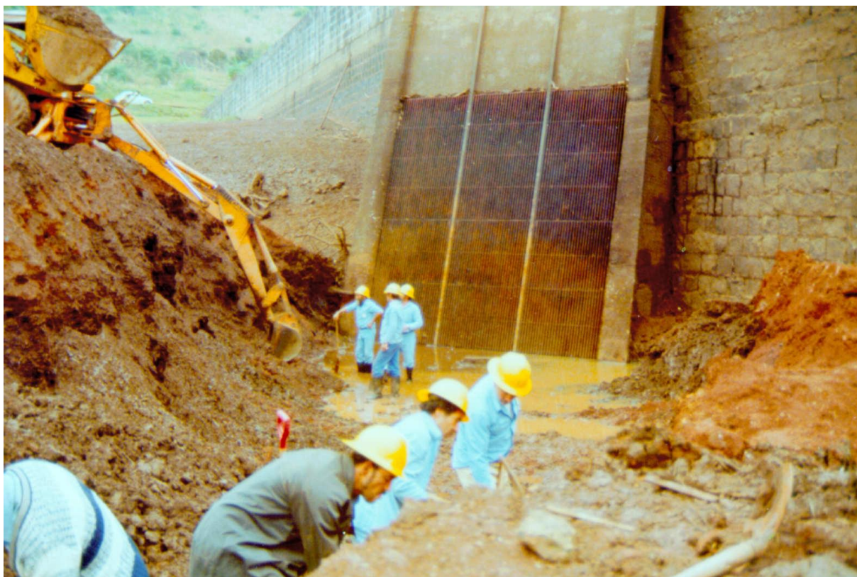
Figura 21 - Desassoreamento da Baragem, Usina Celso Ramos, Faxinal dos Guedes SC.
