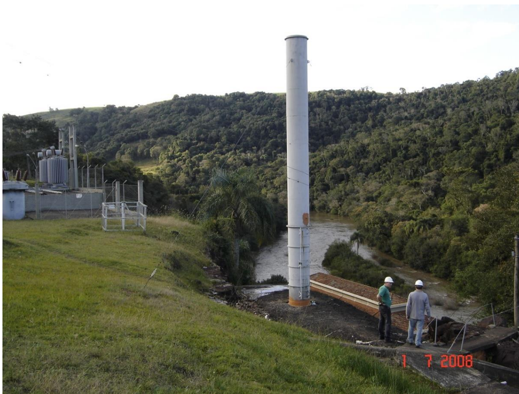
Figura 27 - Chaminé de Equilíbrio, Usina Celso Ramos, Faxinal Dos Guedes SC.
