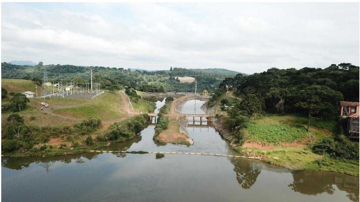
Figura 10 - Entrada do Canal Adutor, Usina Pery, Curitibaanos SC.
