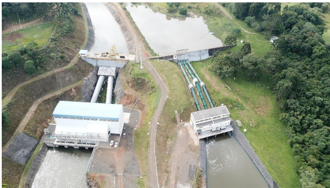
Figura 28 – Conduto forçado metálico, Usina Pery I e II, Curitibaanos SC.
