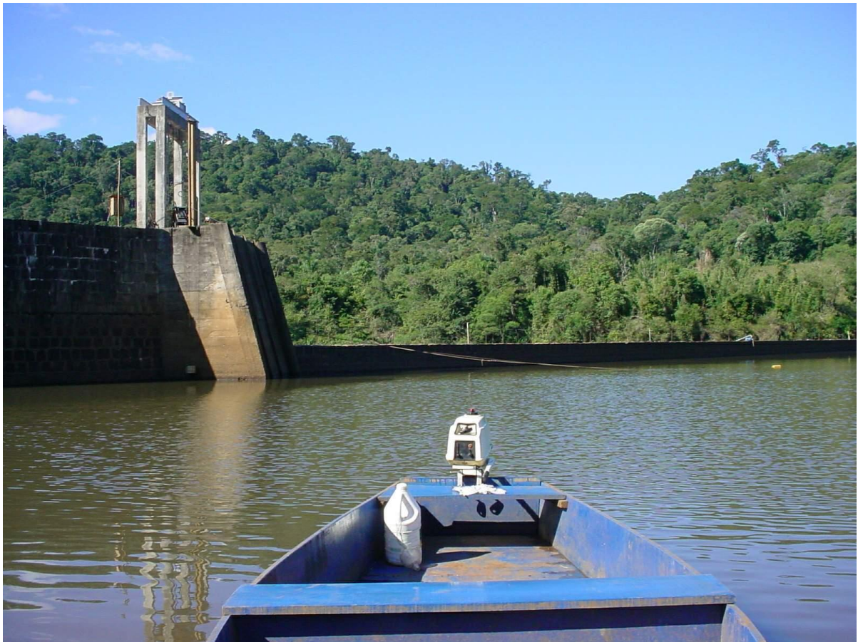
Figura 26 – Tomada de água, Usina Celso Ramos.
