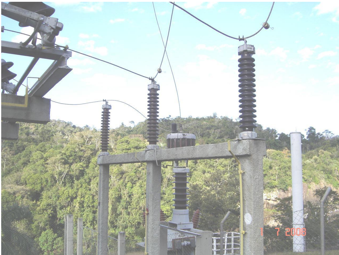
Figura 63 - Para Raio, Usina Celso Ramos, Faxinal dos Guedes SC.
