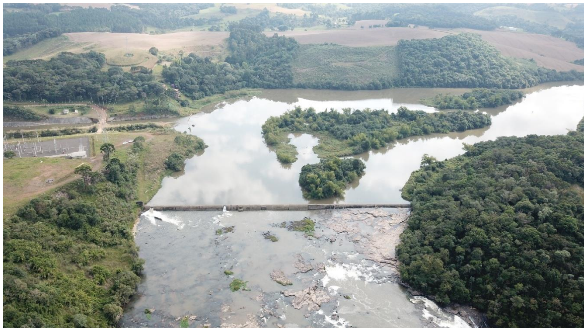
Figura 22 - Reservatório, Usina Pery, Curitibaanos SC.
