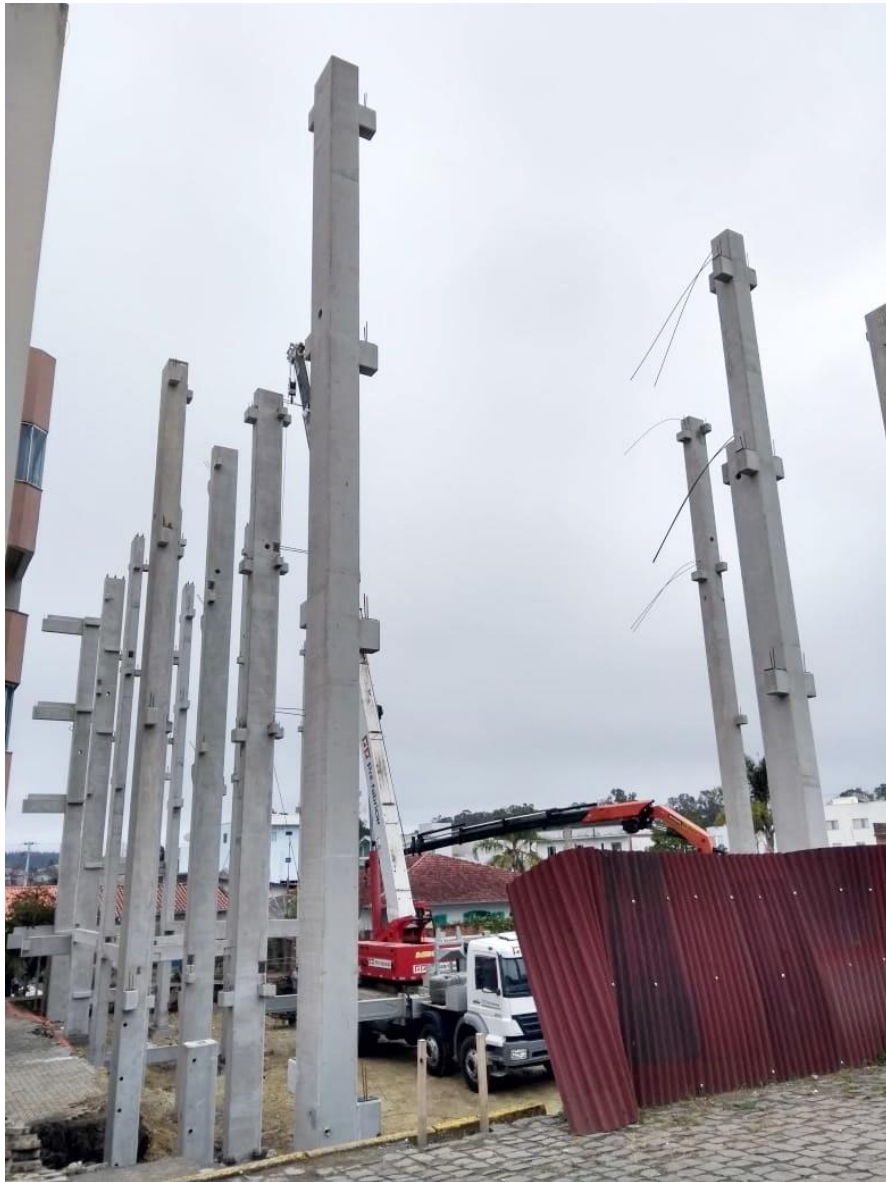
Figura 14: Pilares e vigas sendo instalados. Fonte: (Autor).
