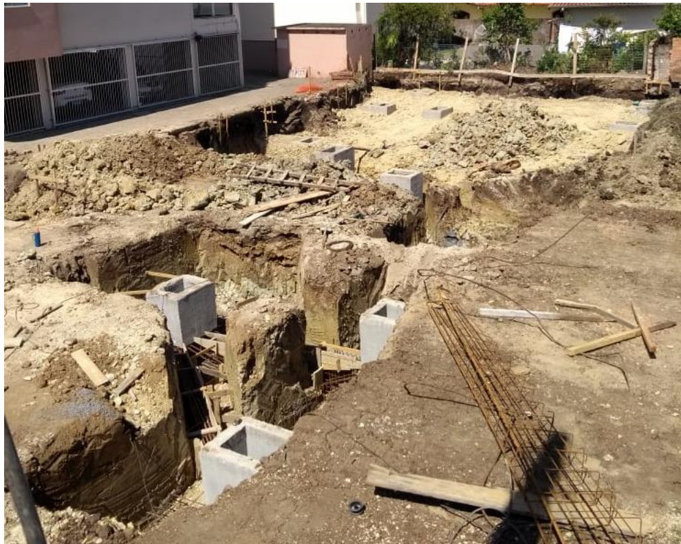
Figura 13: Canteiro de obras com sapatas já colocadas. Fonte: (Autor).
