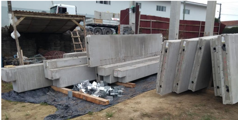
Figura 12: Descarga das peças e empilhamento. Fonte: (Autor).
