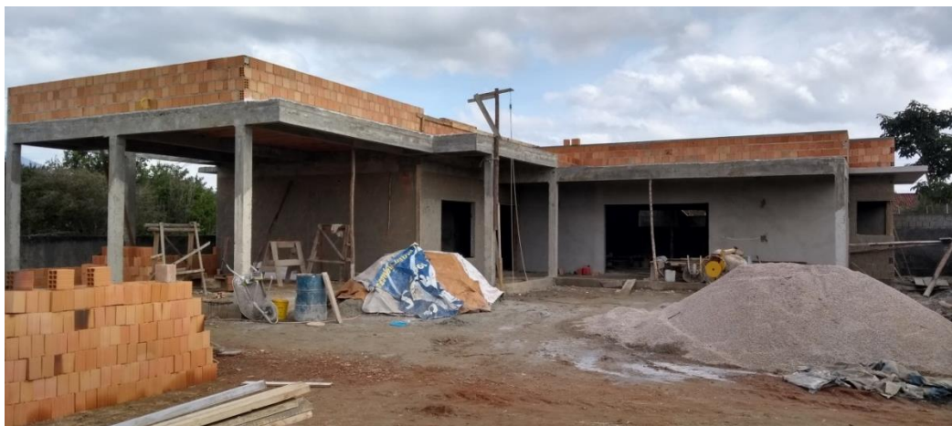
Figura 11: Laje já executada, sendo realizada a platibanda. Fonte: (Autor).
