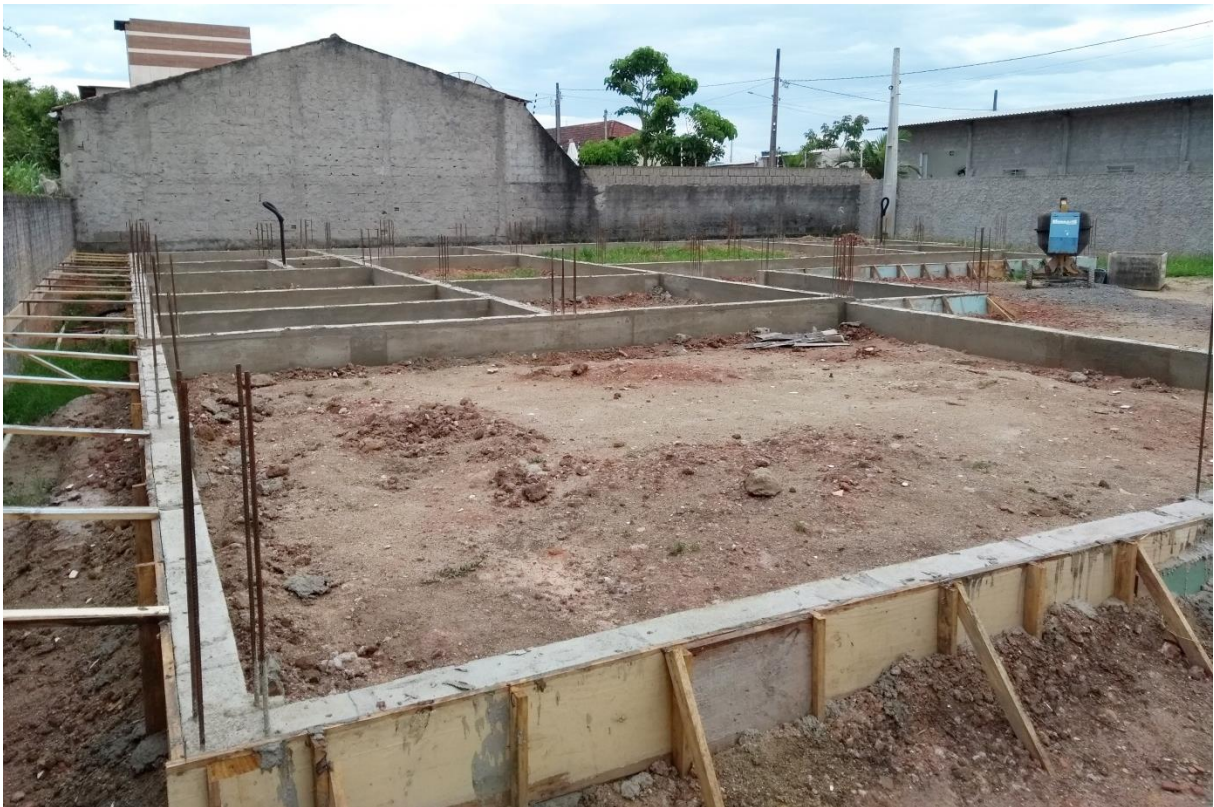
Figura 09: Concretagem de sapatas e viga baldrame. Fonte: (Autor).
