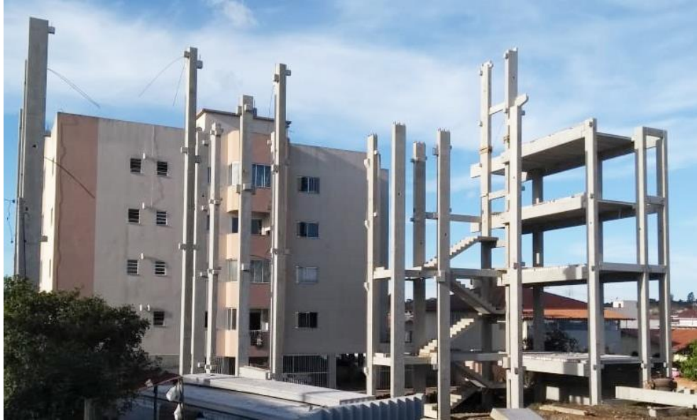
Figura 16: Escadas e lajes sendo instaladas.
