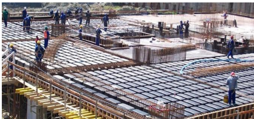
Figura 02: Laje Nervurada. Fonte: (aecweb.com.br).
