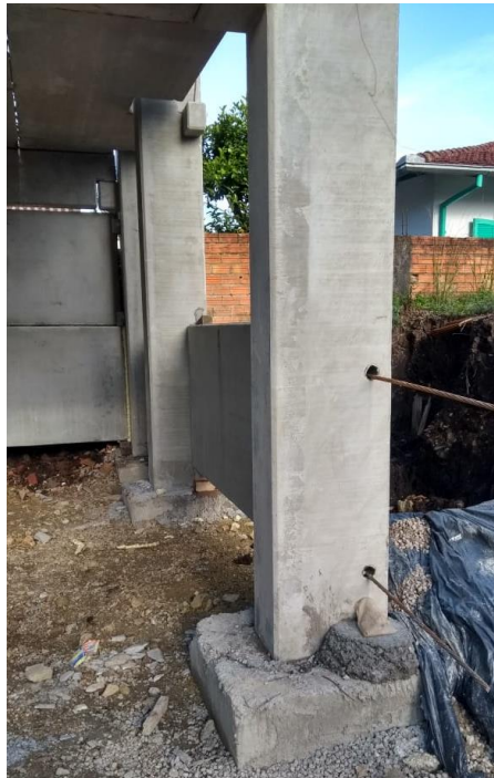
Figura 15: Cortinas sendo instaladas. Fonte: (Autor).
