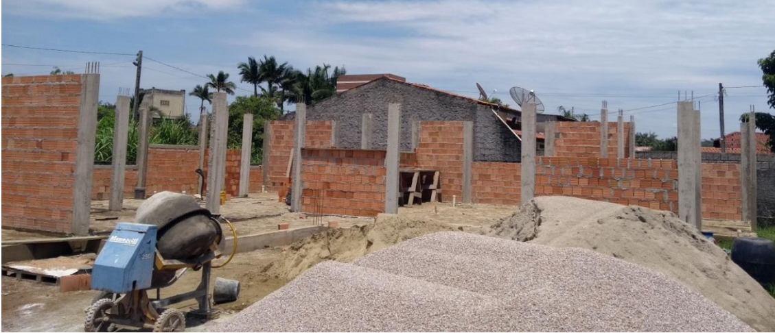
Figura 10: Construção dos pilares e paredes em alvenaria. Fonte: (Autor).
