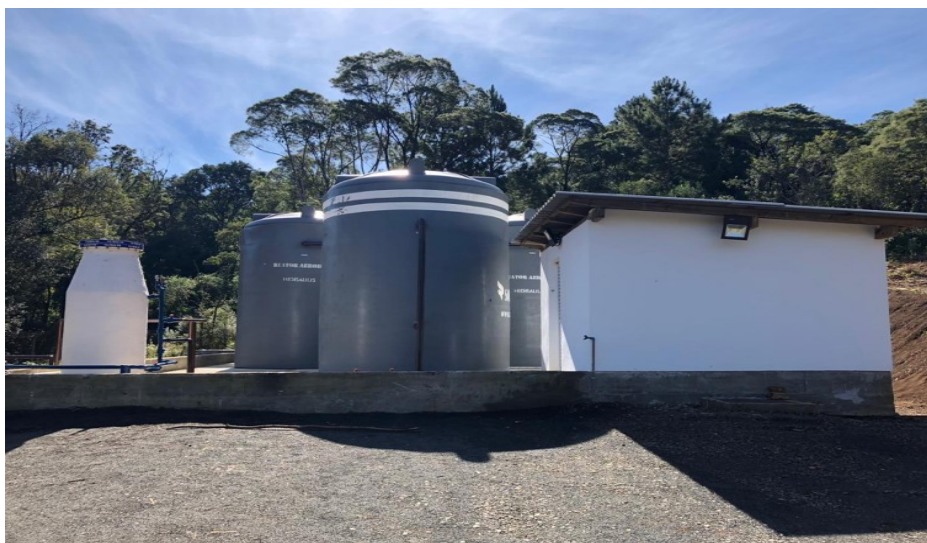
Figura 1– Vista da Estação de Tratamento de Esgoto, Universidade Federal de Santa Catarina em Curitibanos/SC.
