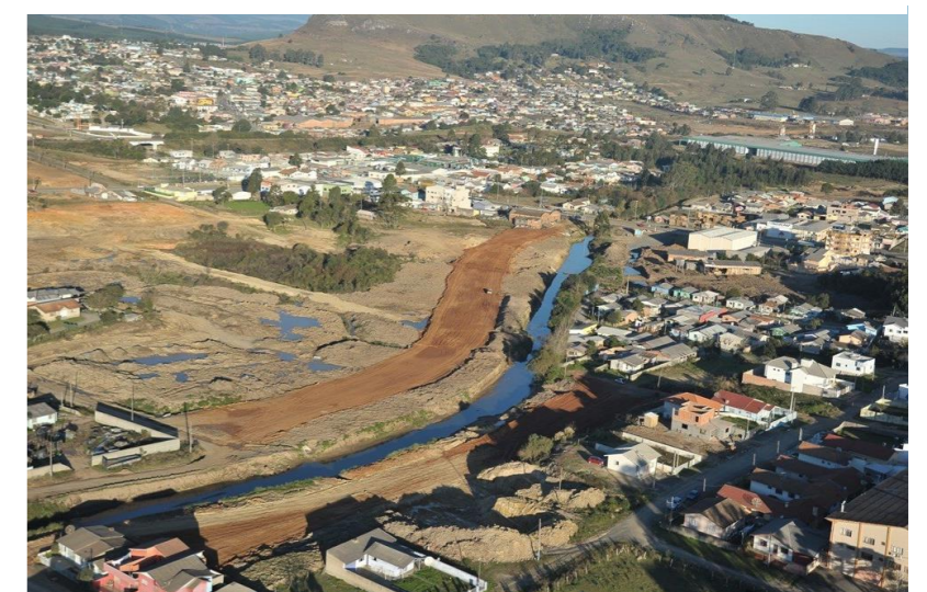
FIGURA 6 - EXECUÇÃO AV. PONTE GRANDE. FONTE: CORREIO LAGEANO
