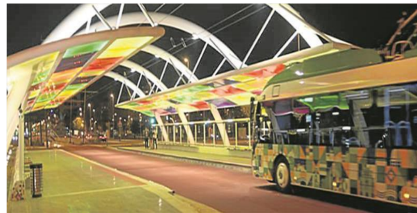
FIGURA 53- ESTAÇÃO DE EMBARQUE. FONTE: PREFEITURA DE CASTELLÓN.
