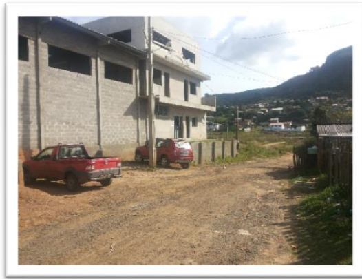
Figura 7 – Edificação Industrial e Multifamiliar, legalizada e com escritura pública no Bairro Habitação.
