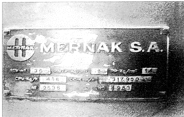
Figura 10: Placa de Identificação da caldeira
