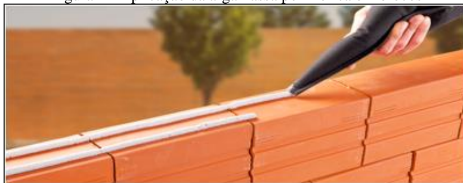
Figura 2 - Aplicação da argamassa polimérica em blocos
