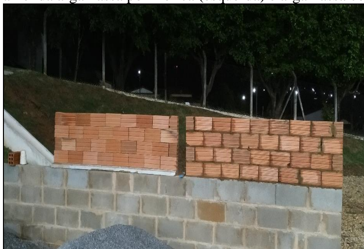
Figura 11 - Painel da argamassa polimérica (esquerda) e argamassa comum (direita)
