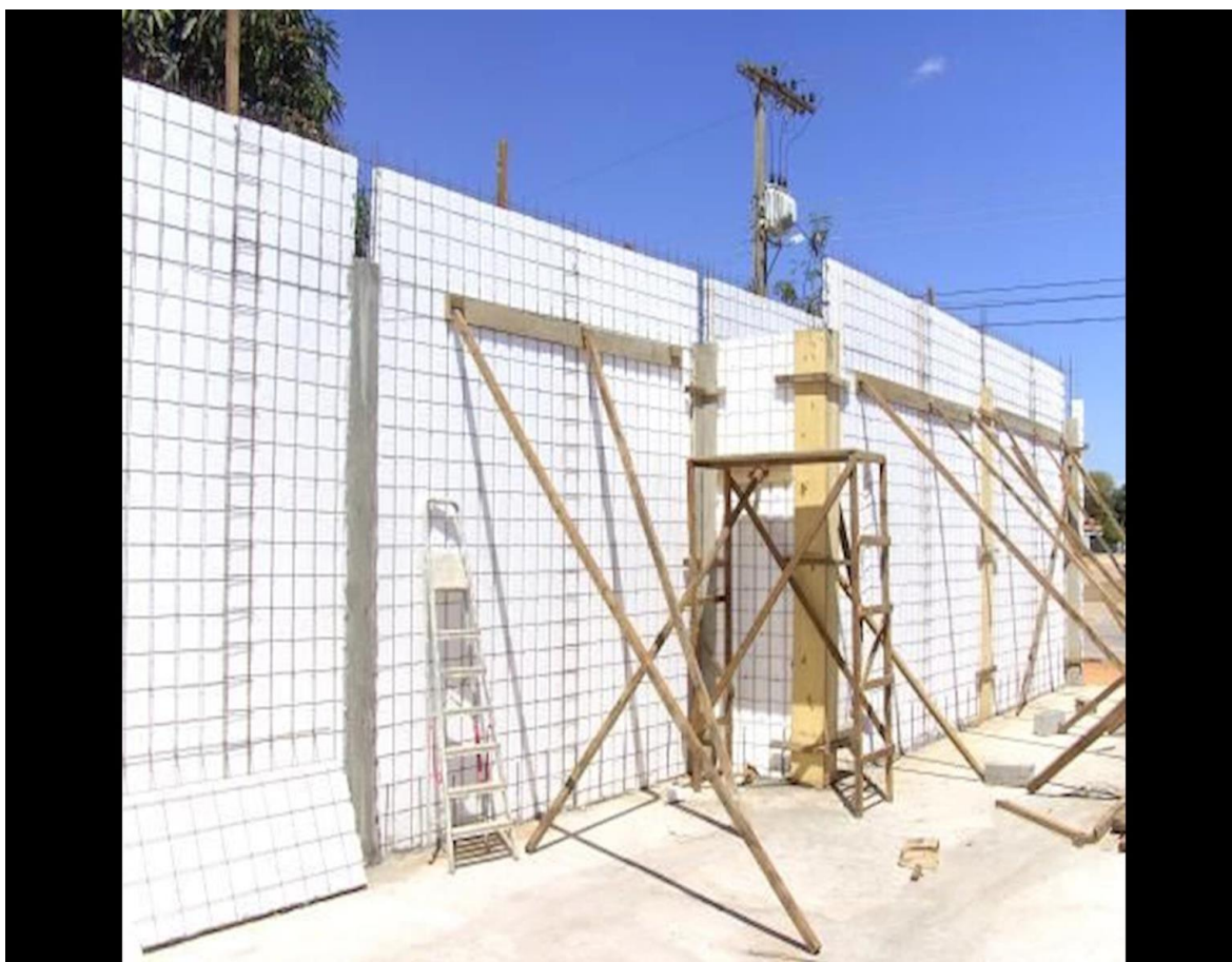
Figura 6: Escoras utilizadas nos painéis
