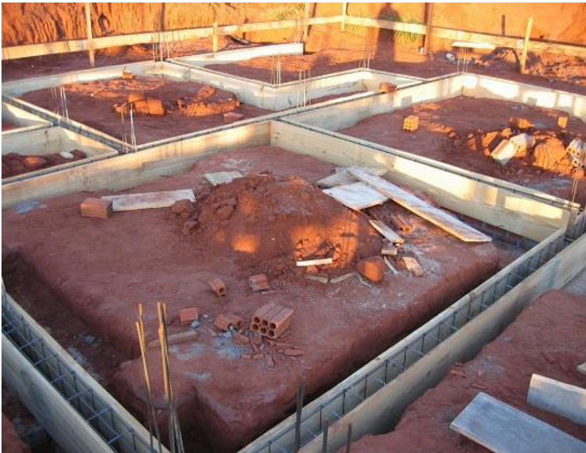
Figura 14: Fundação para casa de alvenaria
