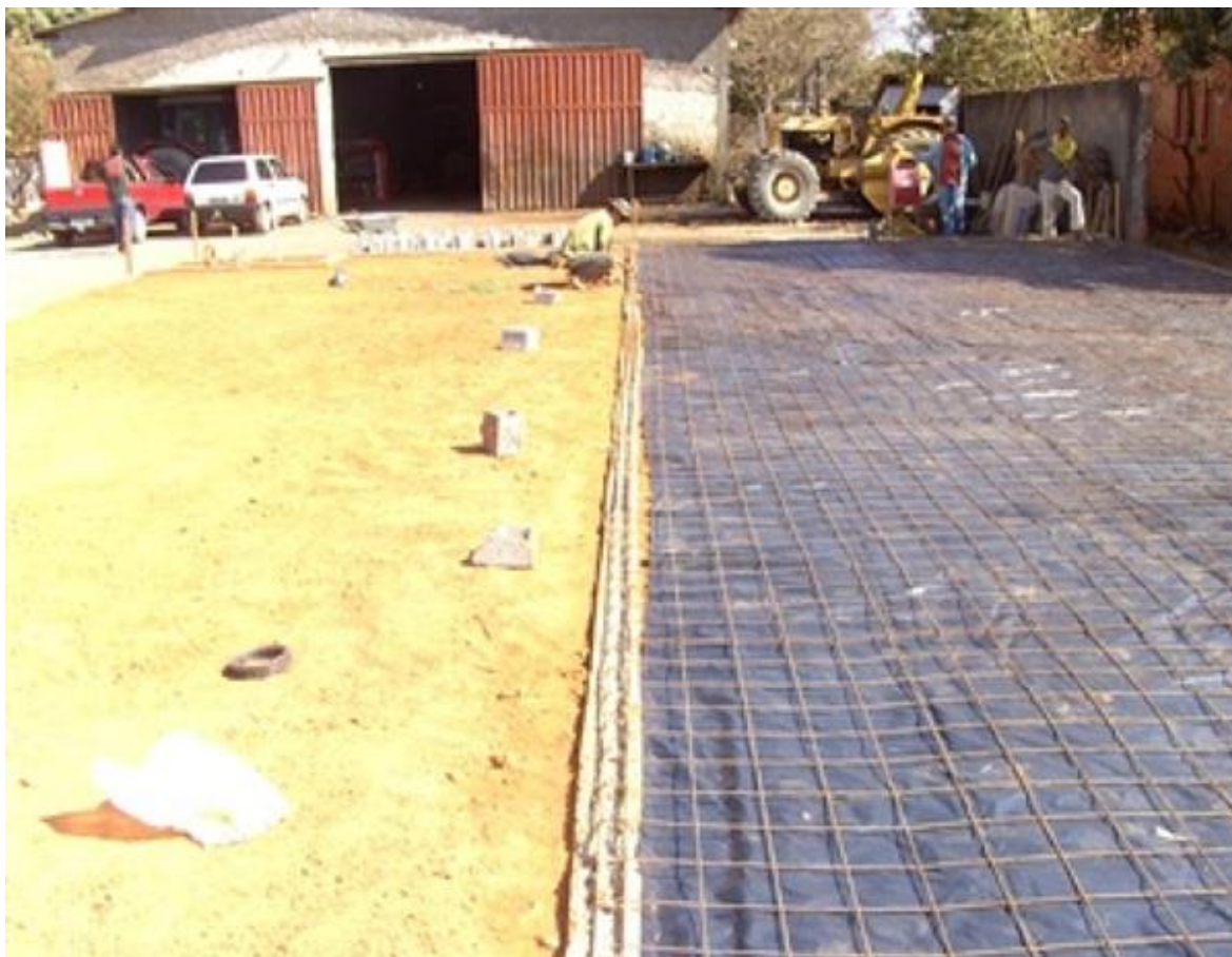
Figura 5: Fundação radier para casa de isopor
