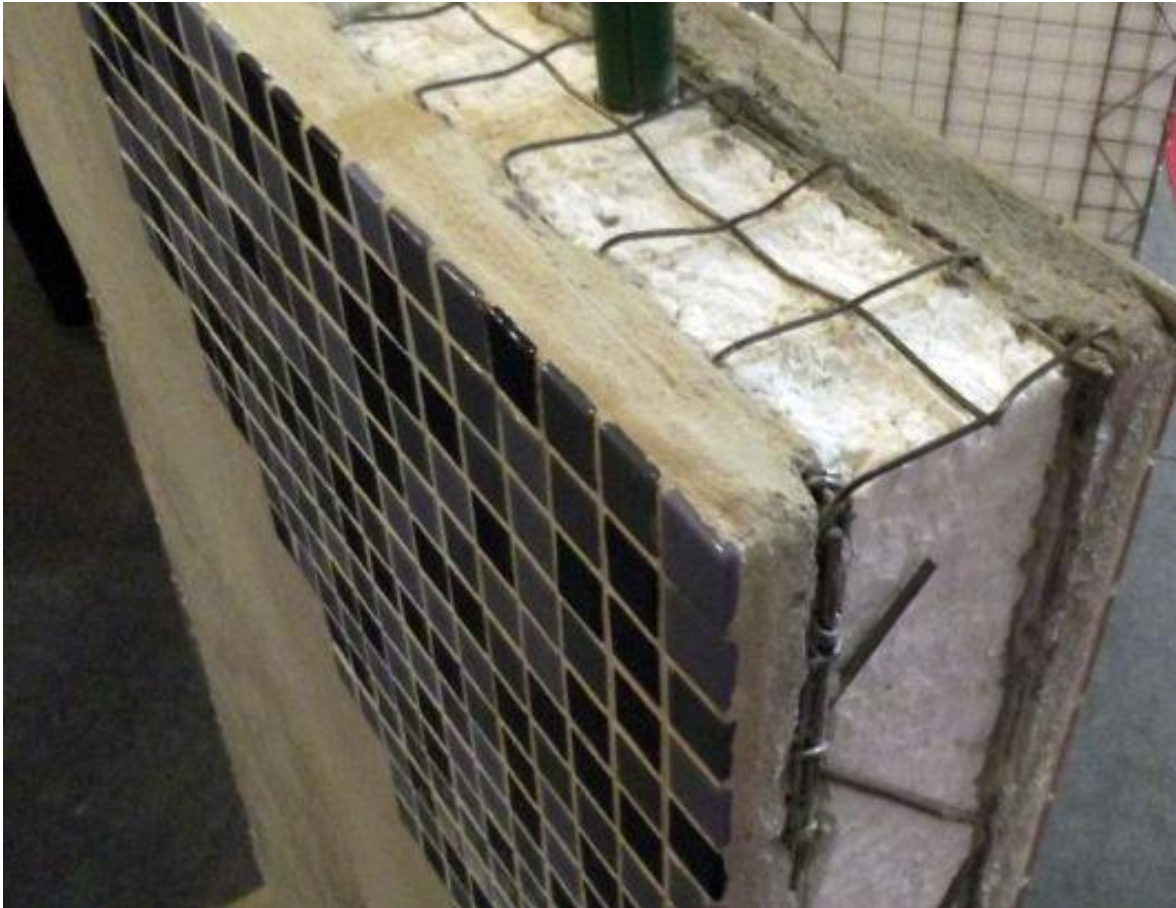
Figura 9: Casa de isopor: parede com revestimento
