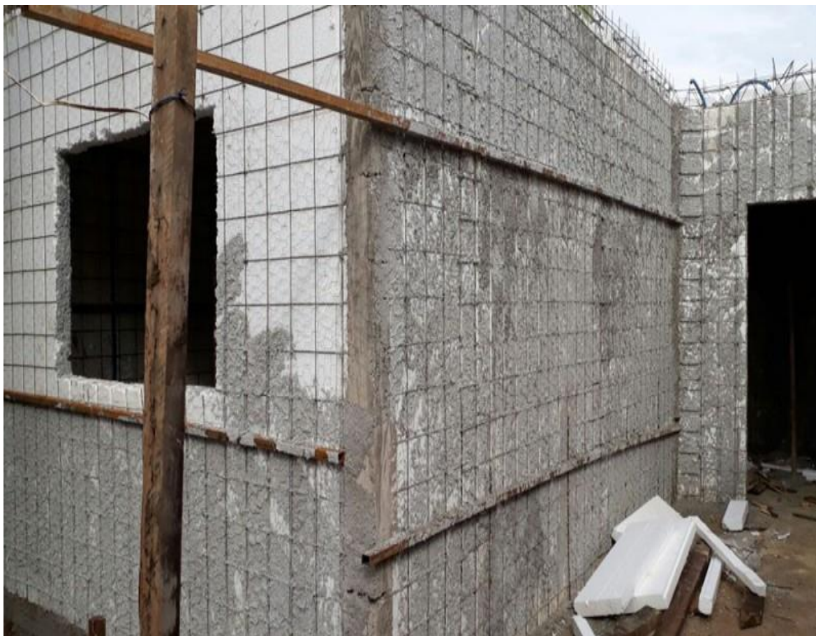
Figura 10: Casa de isopor: parede com revestimento
