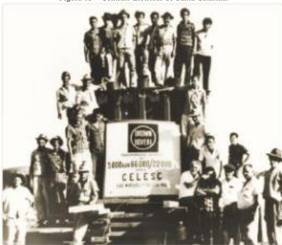
Figura 13 – Centrais Elétricas de Santa Catarina.
