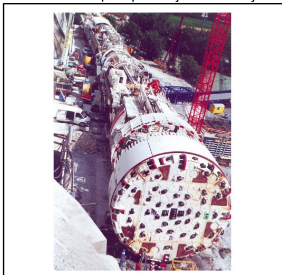
Figura 6 - Tuneladora para perfuração em maciço rochosos
