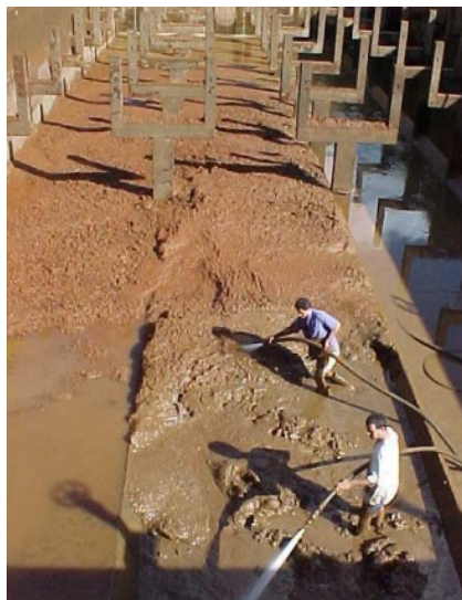
Figura 3 - Limpeza manual de lodos de decantadores.
