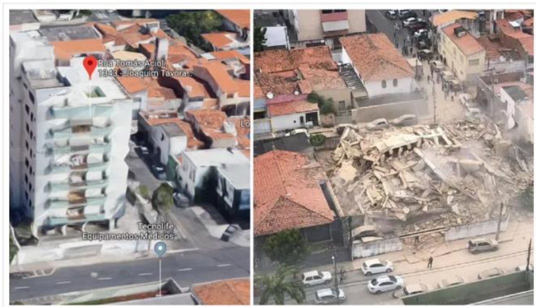
Figura 30 – Edifício Andrea antes e depois do sinistro.
