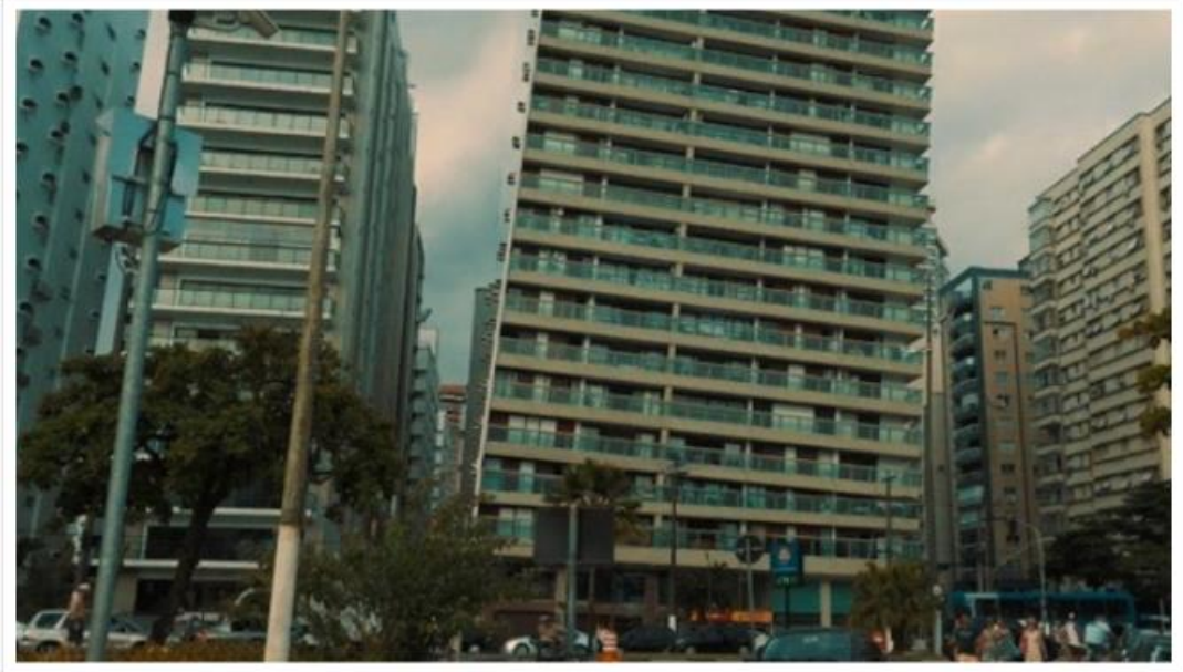
Figura 21 – Prédios que sofreram recalque na Orla de Santos/ SP.
