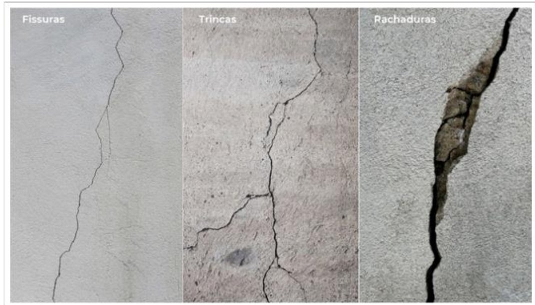
Figura 18 – Diferentes formas de fissuras
