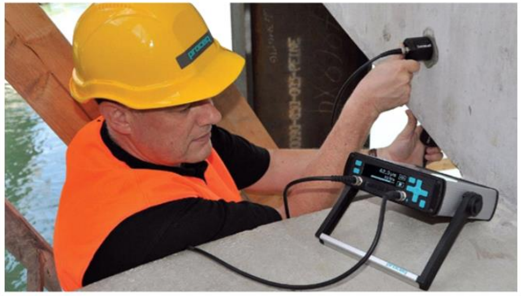
Figura 27 – Utilização de ultrassom na estrutura.
