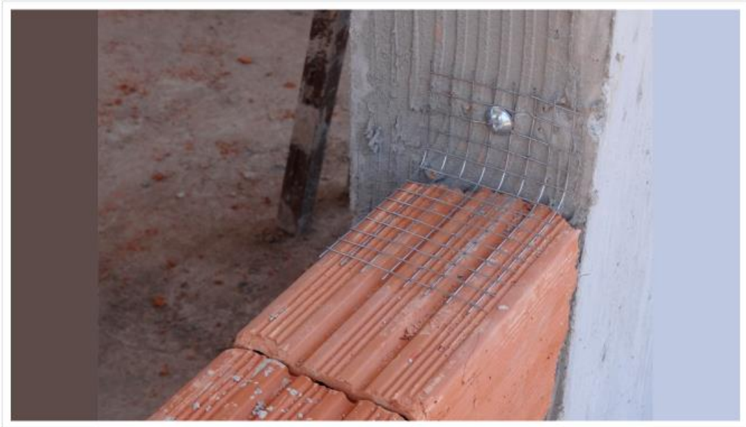
Figura 16 – Tela entre alvenaria e pilar.
