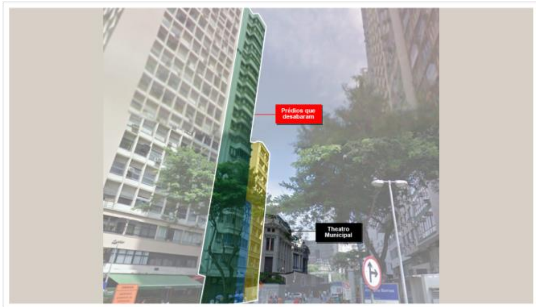
Figura 29 – Prédios que desabaram no Rio de Janeiro.
