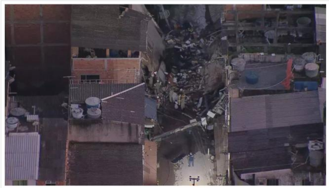
Figura 32 – Destroços do desabamento do prédio na zona oeste do Rio.
