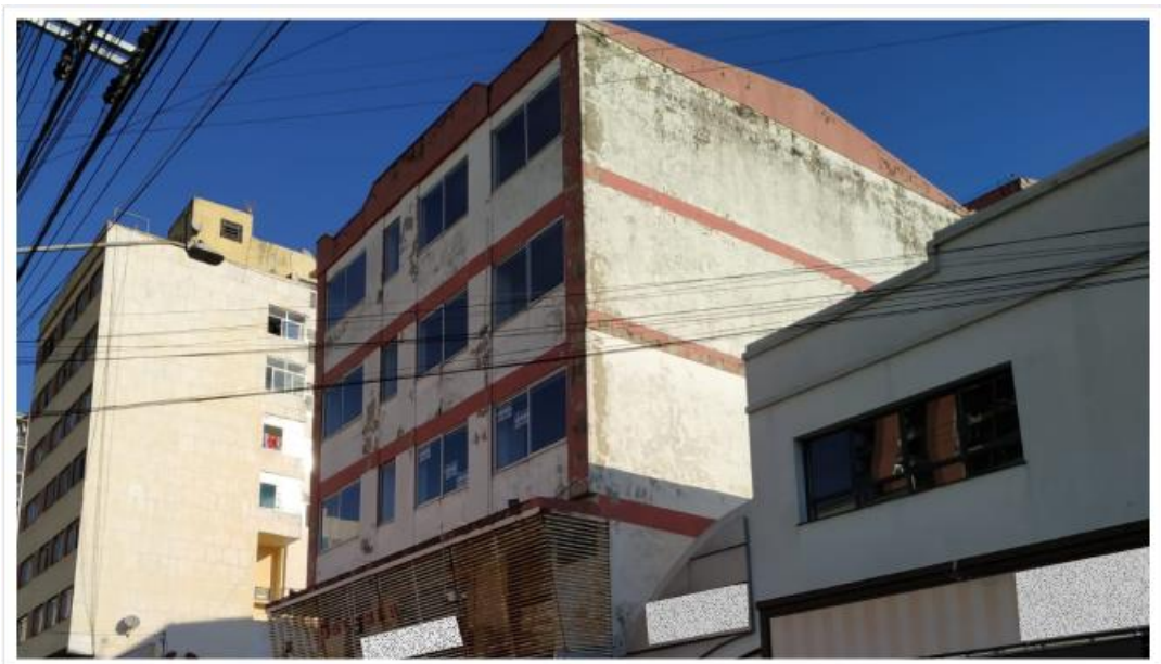
Figura 23 – Exemplo de edificação predial normal (N).
