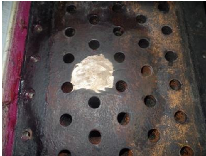
Figura 33 Furo isolado após testes
