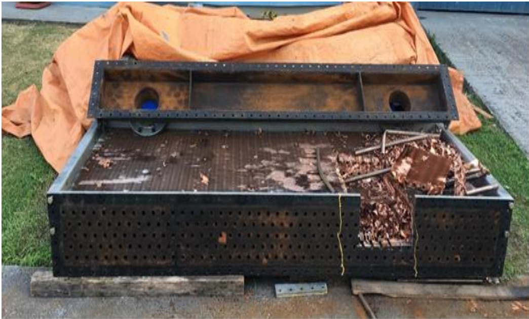
Figura 7 Trocador de calor após cortes para retirada do tubo comprometido.
