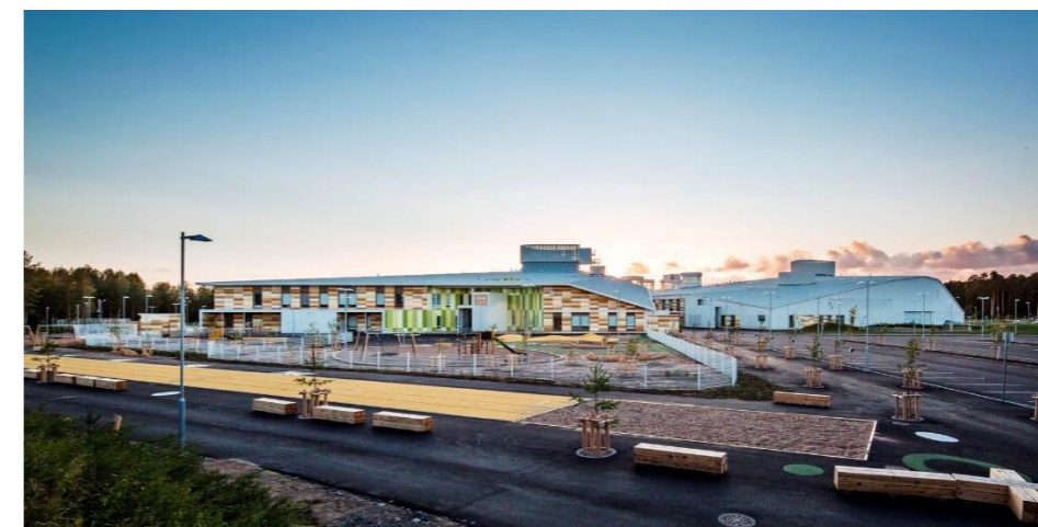
Fachada Frontal do Centro Comunitário
