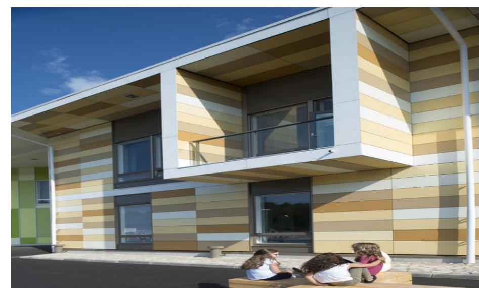
Detalhes da Fachada
