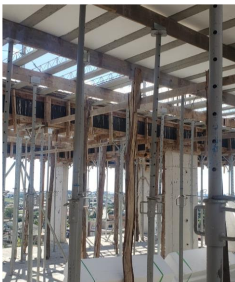
Figura 6 - Escoramento e disposição das vigotas
