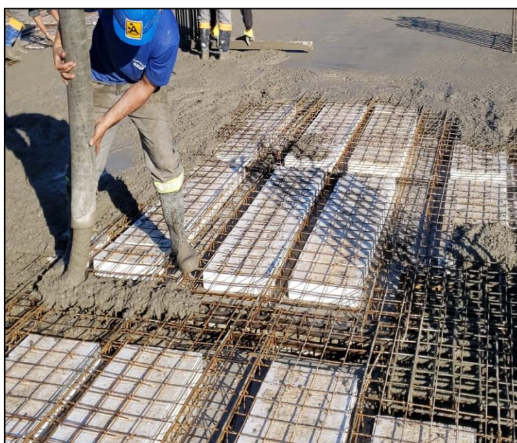
Figura 9 - Concretagem da laje
