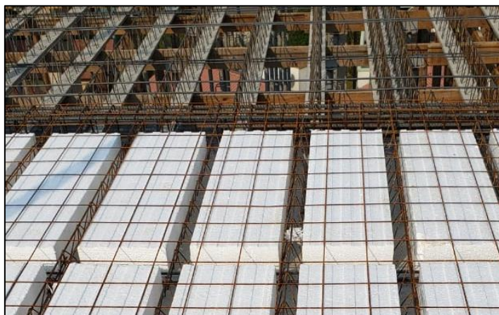
Figura 7- Disposição dos elementos de enchimento
