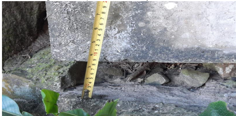
Figura 46 -Solapamento das fundações do encontro
