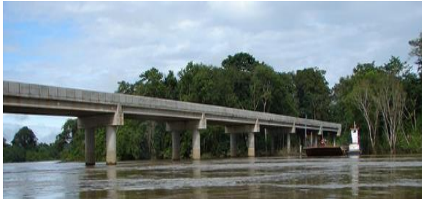
Figura 7 - Ponte em vigas
