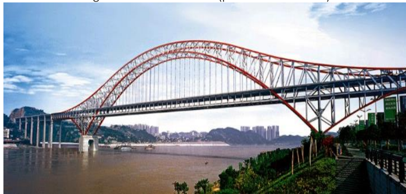
Figura 9 – Ponte em arco (ponte Chaotianmen)
