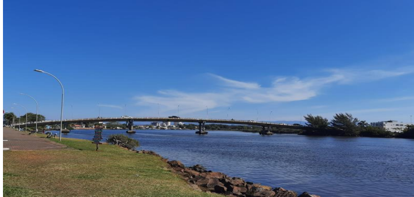
Figura 33 – Ponte de concreto Anita Garibaldi sobre o Rio Mampituba
