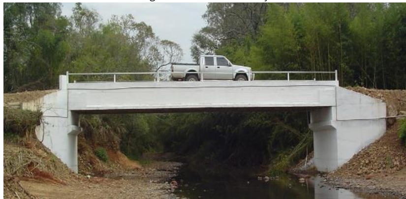
Figura 12 – Ponte em laje
