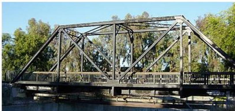
Figura 8 – Ponte treliçada modelo Warren
