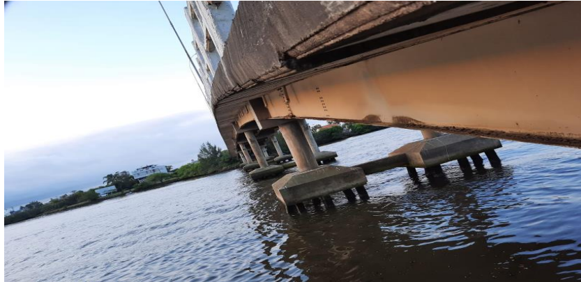
Figura 34 – Vista lateral esquerda da ponte de concreto Anita Garibaldi
