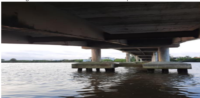
Figura 36 – Vista inferior do tabuleiro da ponte Anita Garibaldi
