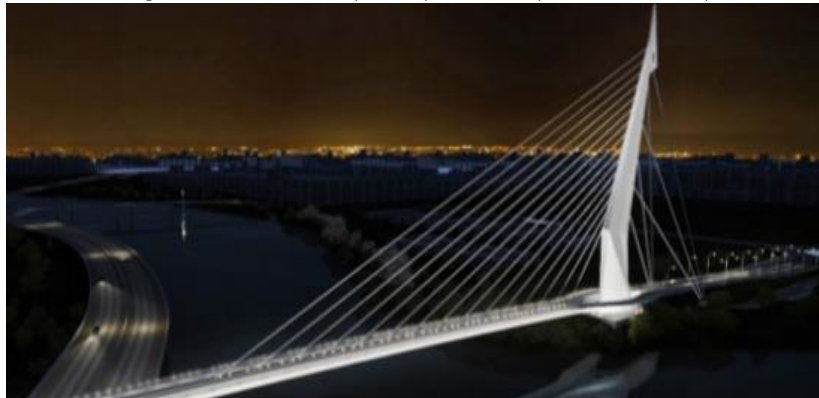
Figura 10 – Ponte suspensa por cabos (Ponte do saber)
